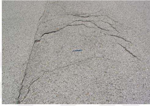
Resim 2.48 Orta şiddetli kayma çatlağı (Gürer 2014)
