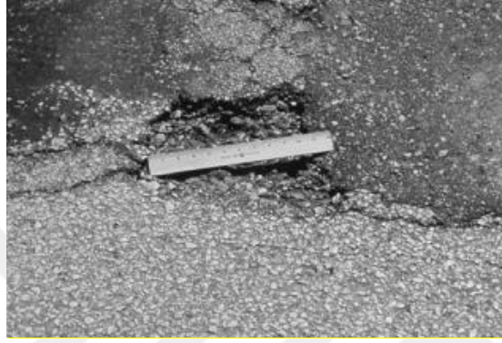
Resim 2.35 Düşük şiddetli oyuk (Gürer 2014)
