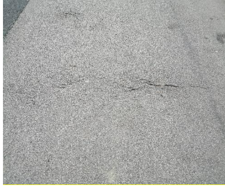
Resim 2.47 Düşük şiddetli kayma çatlağı (Gürer 2014)
