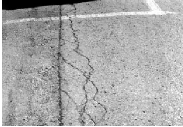
Resim 2.20 Orta şiddetli kenar çatlağı (Gürer 2014)
