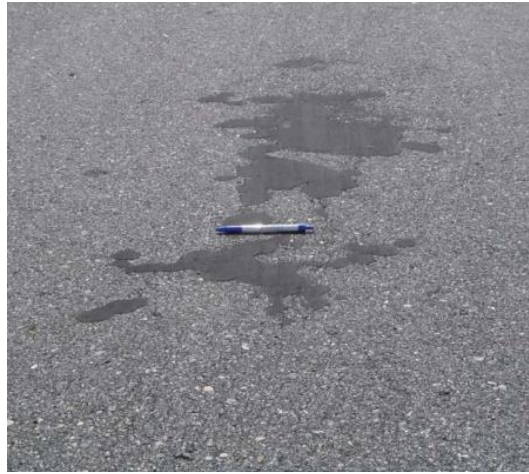
Resim 2.4 Düşük şiddetli kuma (Gürer 2014)
