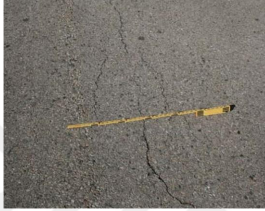
Resim 2.1 Düşük şiddetli timsah sırtı çatlak (Gürer 2014)
