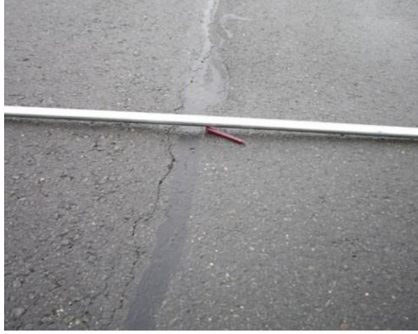
Resim 2.16 Düşük şiddetli çöküntü (Gürer 2014)
