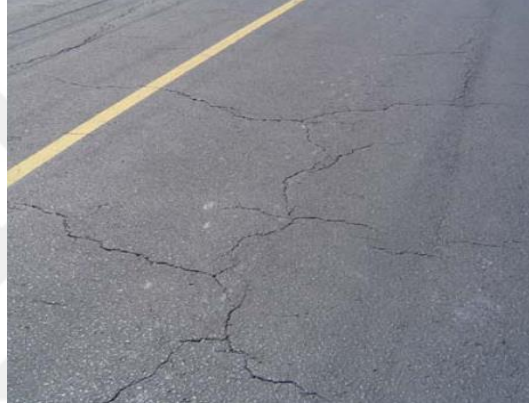
Resim 2.8 Orta şiddetli blok çatlak (Gürer 2014)
