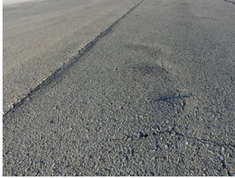
Resim 2.50 Düşük şiddetli kabarma (Gürer 2014)
