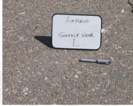
Resim 2.53 Düşük şiddetli aşınma ve sökölme (Gürer 2014)
