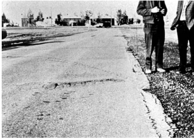
Resim 2.11 Orta şiddetli kabarma ve oturma (Gürer 2014)
