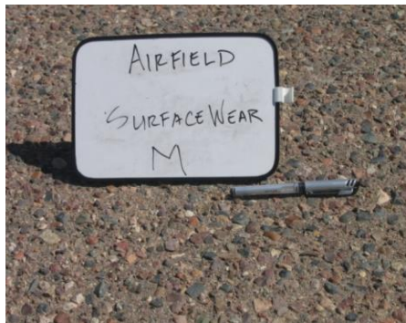
Resim 2.54 Orta şiddetli aşınma ve sökölme (Gürer 2014)
