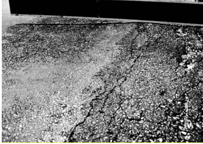
Resim 2.12 Yüksek şiddetli kabarma ve oturma (Gürer 2014)
