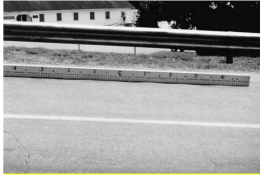
Resim 2.13 Düşük şiddetli ondülasyon (Gürer 2014)
