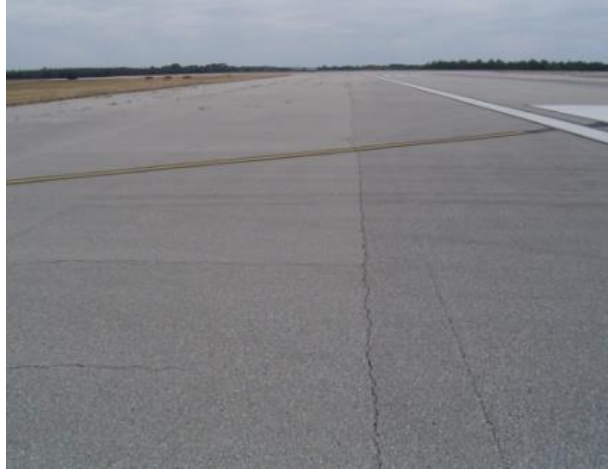
Resim 2.23 Orta şiddetli yansıma çatlağı (Gürer 2014)
