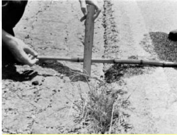
Resim 2.26 Orta şiddetli kenar/banket düşüklüğü (Gürer 2014)
