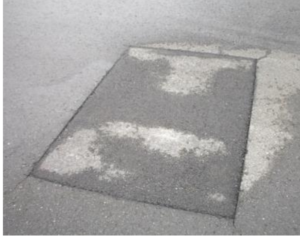
Resim 2.31 Düşük şiddetli yama (Gürer 2014)
