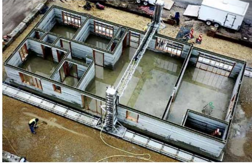
Şekil 3.4 Kontur üretimi prosesinin üretim şeması
