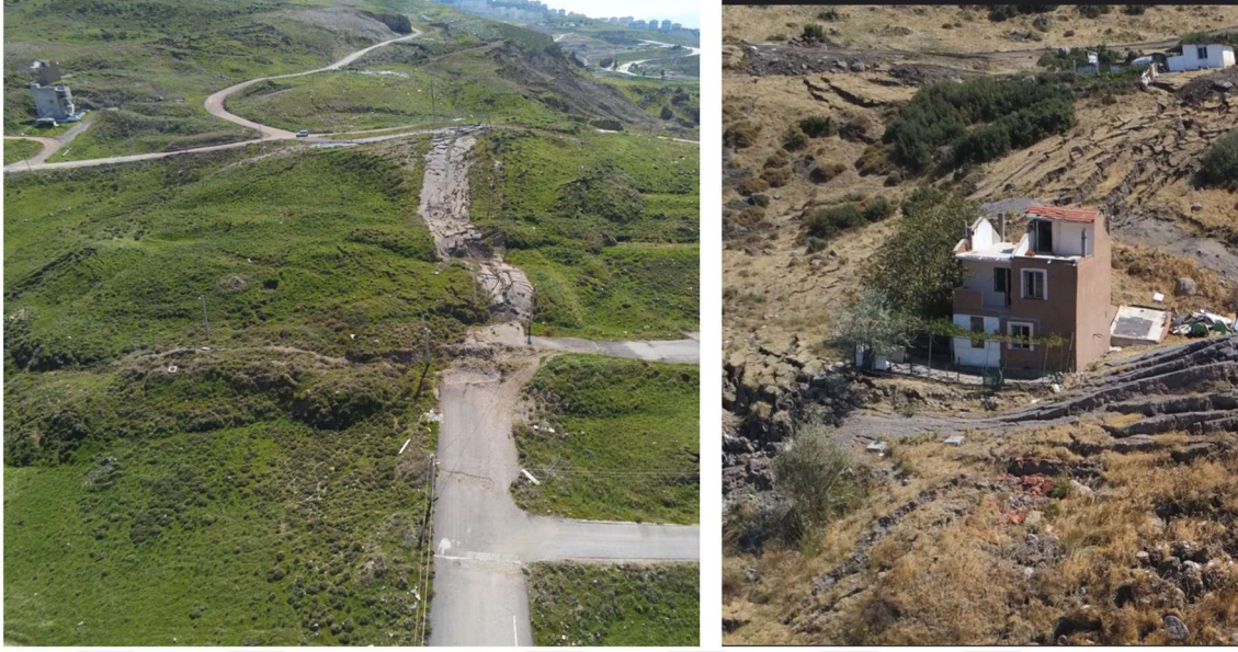
Resim 5.4 Heyelan sonucunda yapılarda görülen hasarlar.
