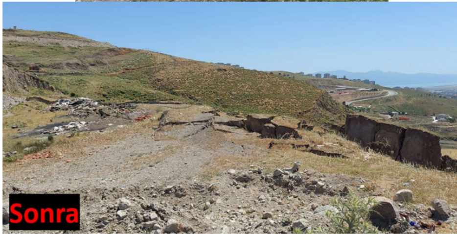
Resim 5.3 Deprem öncesinde ve sonrasında gerçekleşen yüzey deformasyonları.
