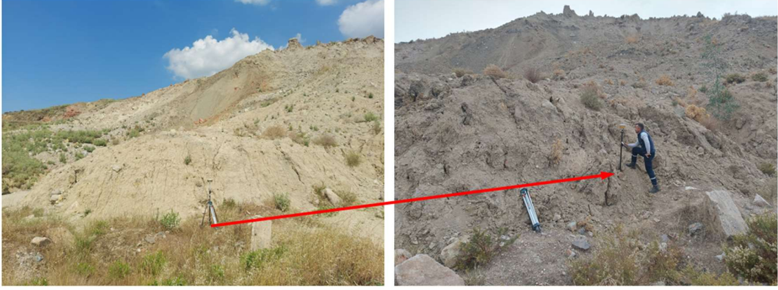
Resim 5.7 Heyelan bölgesinde toprak altında kalan 17 numaralı nokta.
