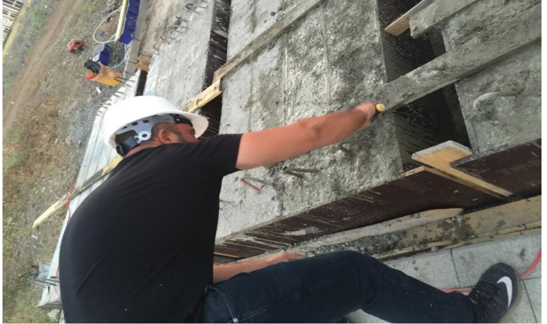
Şekil 3.12. Beton döküm işleminden sonra beton yüzeylerinin düzeltilmesi
