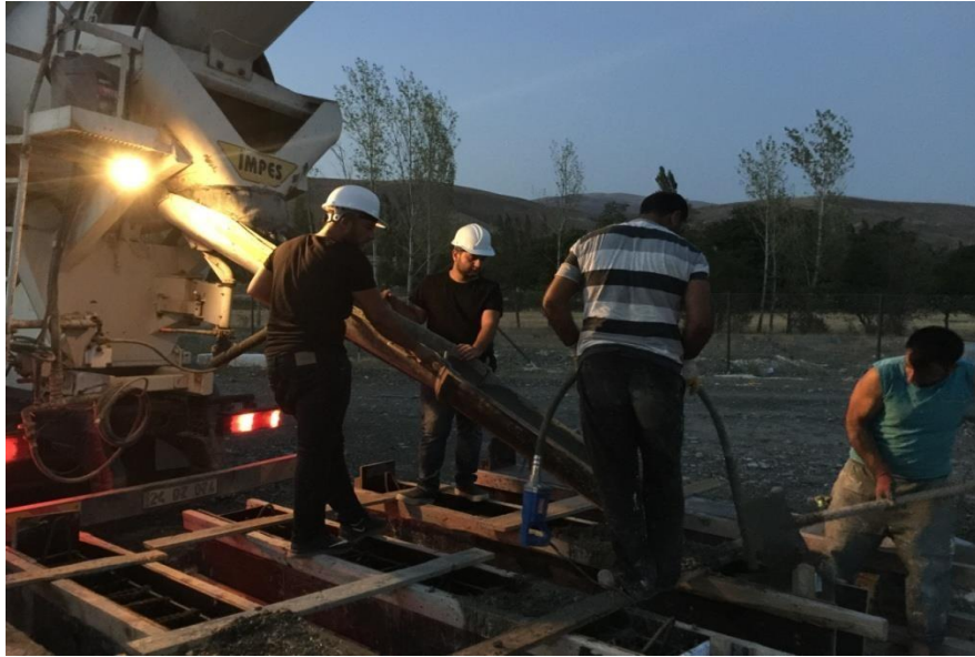
Şekil 3.11. Beton döküm işlemi sırasında vibratör işlemi
