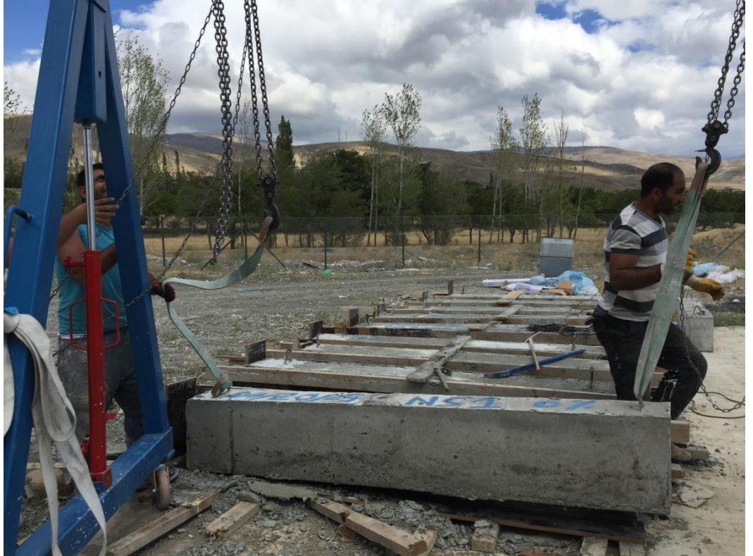
Şekil 3.16. Betonarme kirişlerinin laboratuvar ortamına taşınması
