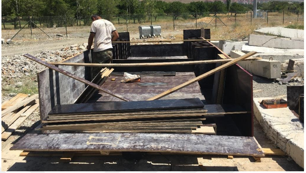
Şekil 4.13. Betonarme kolonları için kalıp hazırlanması.
