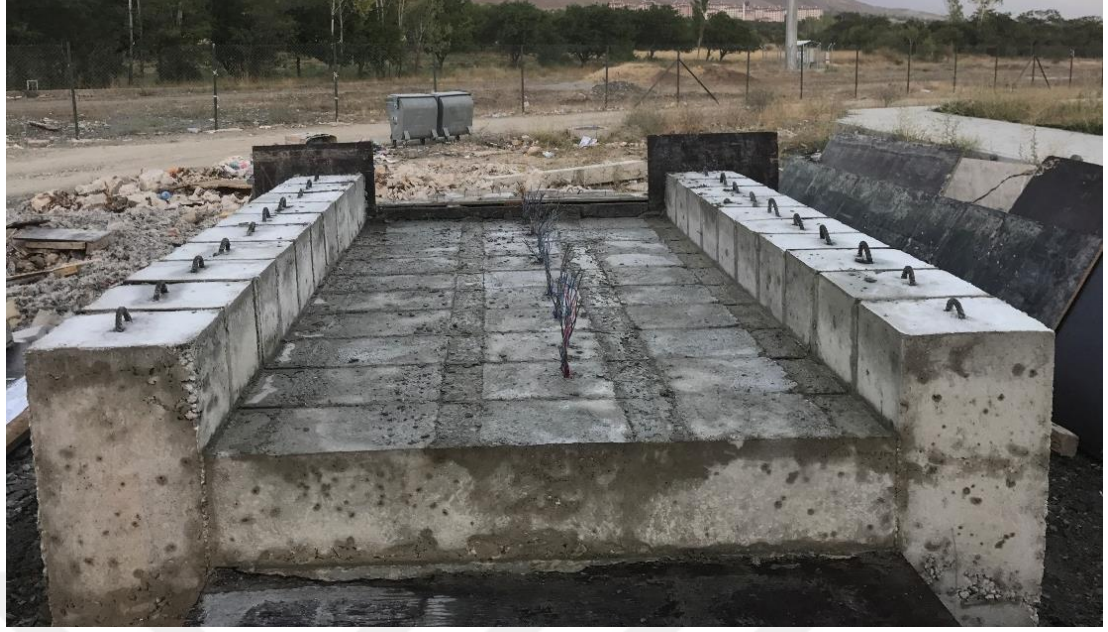
Şekil 4.17. Kalıptan çıkartılan betonarme kolonlar.
