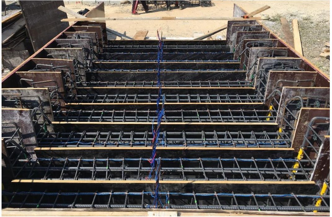
Şekil 4.14. Betonarme kolon donatı kafeslerin kalıba yerleştirilmesi.
