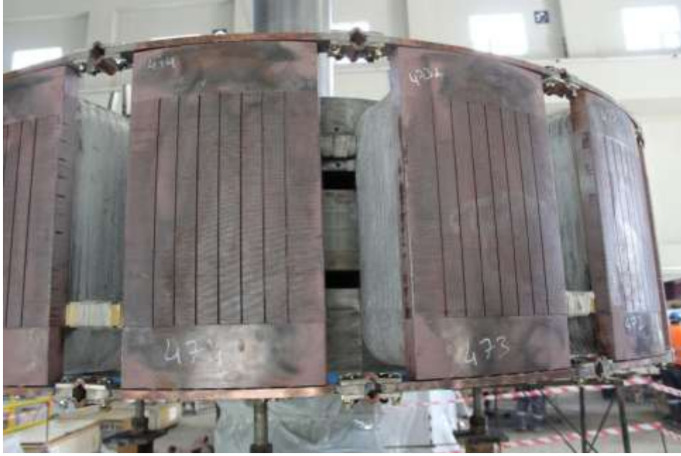
Şekil. 20 Manyetik kutup montajı ve kutup ayağı görüntüsü
