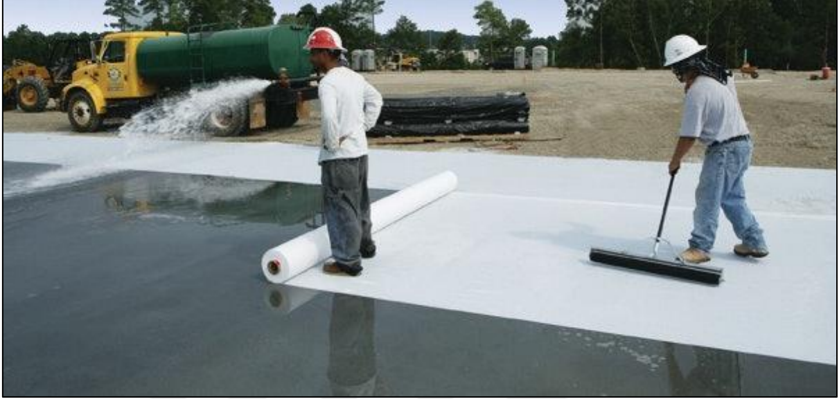
Şekil 18. Beton yollarda membran kürünün uygulanması (Anonymous 2007).
