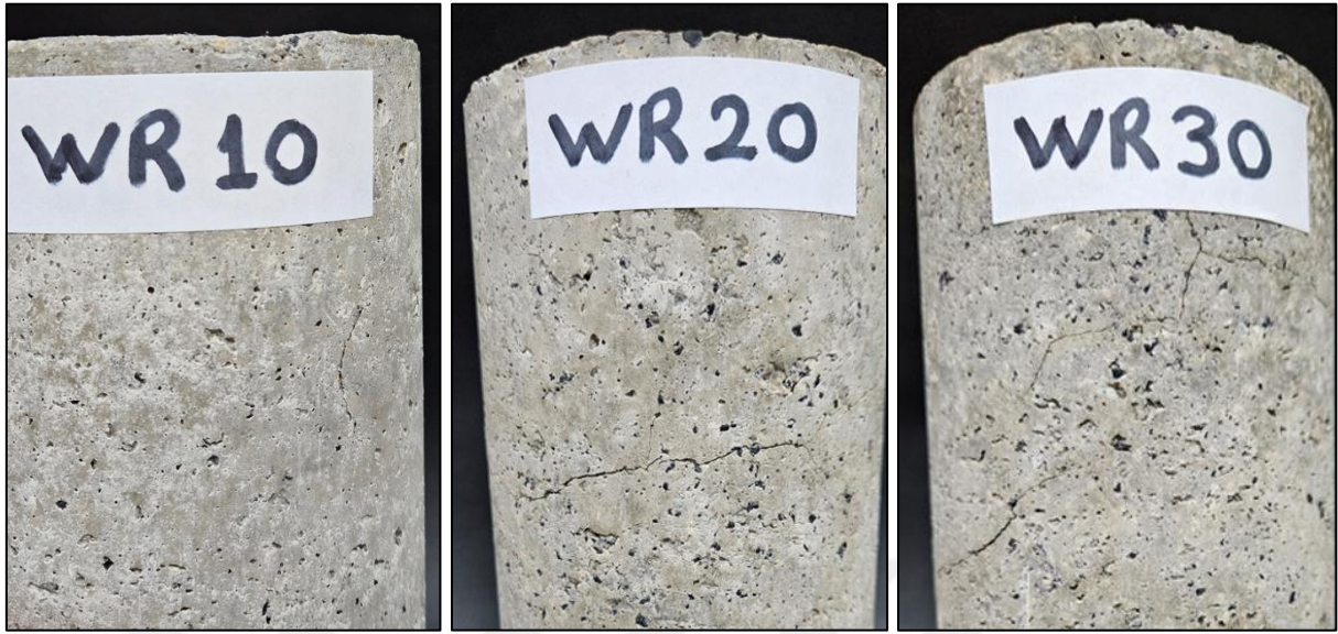
Şekil 95. 300 donma-çözünme döngü sonrası SSB numunelerindeki yüzey çatlakları.
