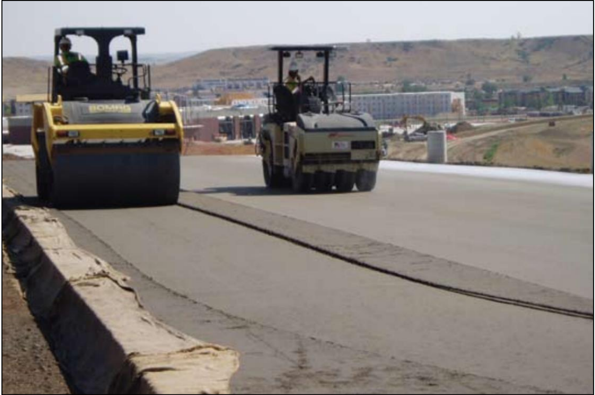
Şekil 9. SSB yolların sıkıştırılması (Harrington et al. 2010).
