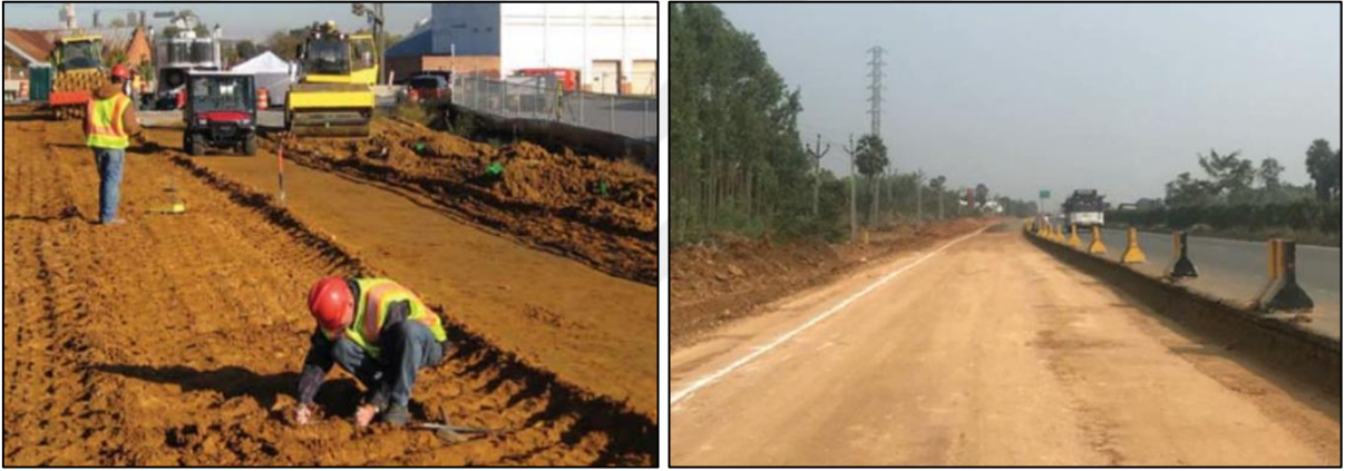
Şekil 6. SSB yolun yerleştirilmeden önce temel tabakasının hazırlanması (Harrington et al. 2010; Anonymous 2019c).
