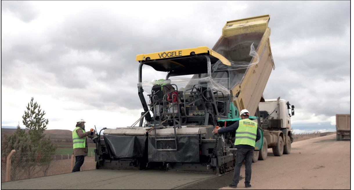
Şekil 8. SSB yolun yerleştirilmesi (Anonymous 2019b).
