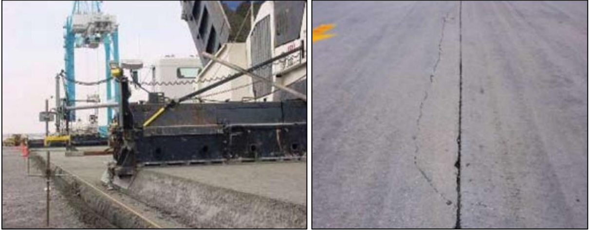
Şekil 14. İkinci tabakada kullanılan serme pabucu ve birinci tabaka bağlantısından bitişik ikinci şeritten yansıyan boyuna çatlak (Harrington et al. 2010).
