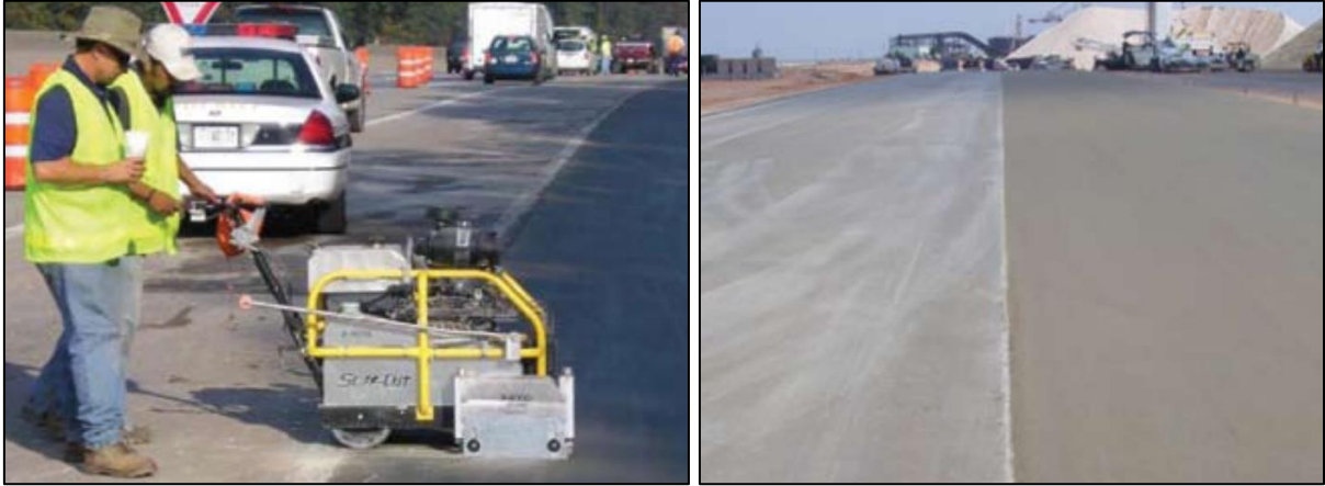
Şekil 15. SSB yollarda enine ve boyuna kesilmiş derzler (Harrington et al. 2010).
