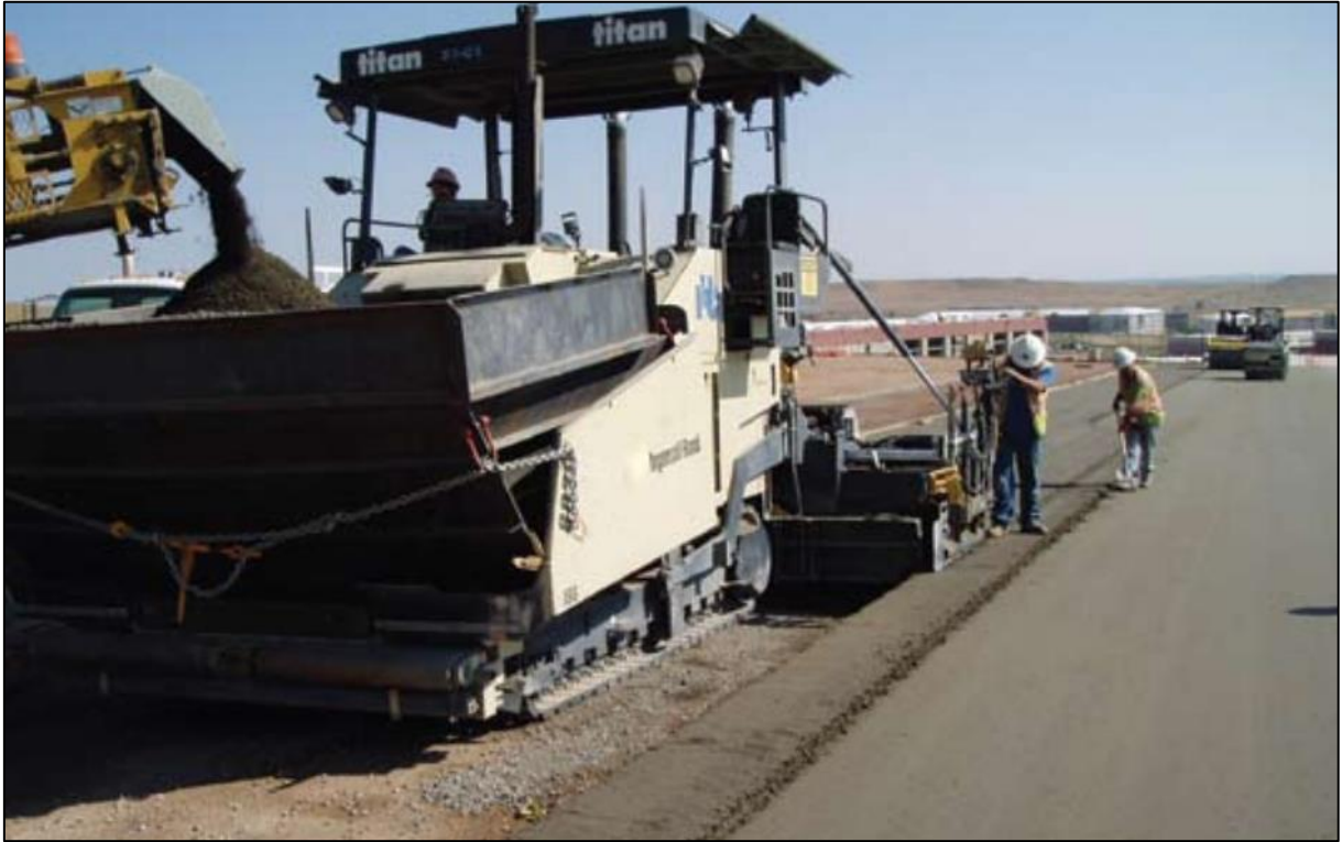
Şekil 12. SSB yollarda boyuna taze derz yapımı (Harrington et al. 2010).
