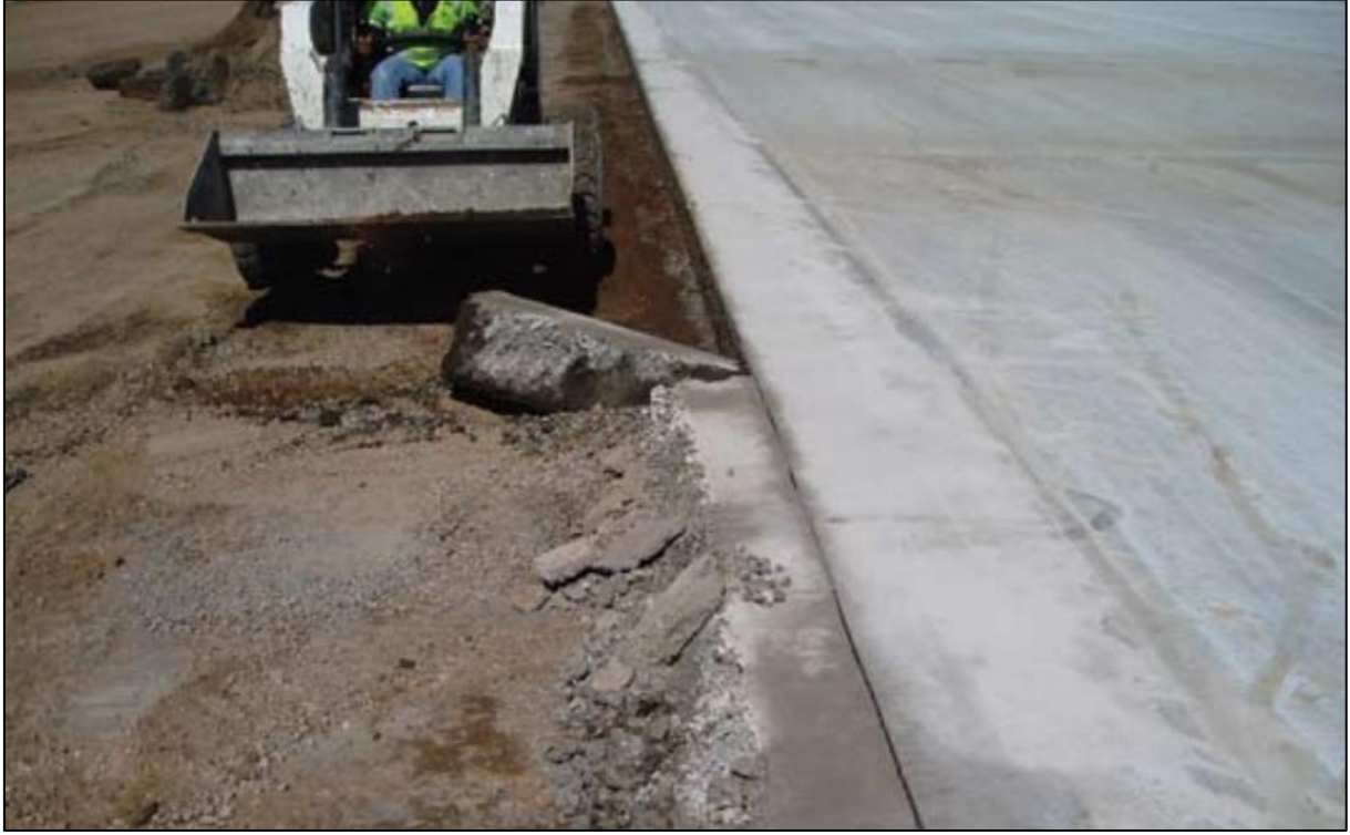
Őekil 13. SSB yollarda boyuna soėuk derzlerin oluřturtulması (Harrington et al. 2010).
