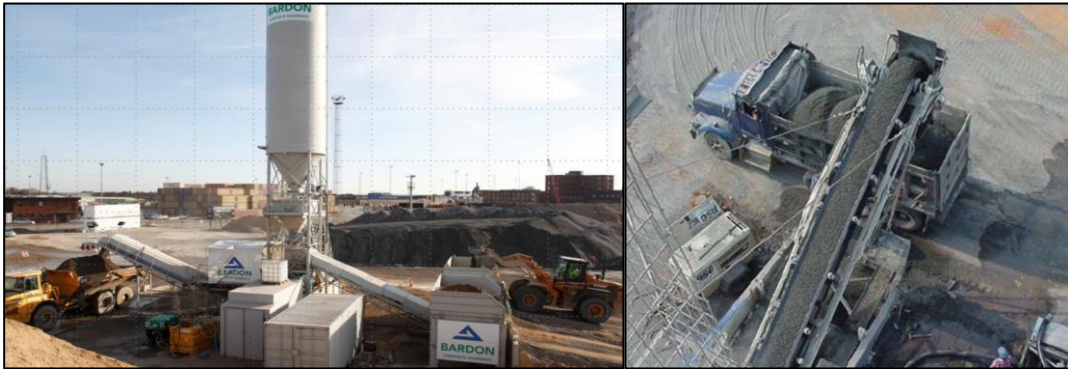
Şekil 7. SSB yolun üretilmesi ve kaplama sahasına taşınması (Harrington et al. 2010; Anonymous 2017a).
