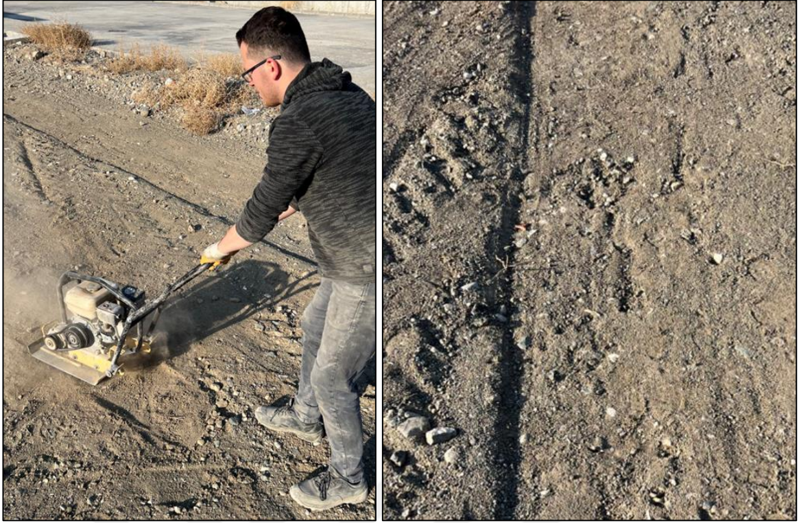
Şekil 33. SSB plakların dökümü öncesi zeminin kompaktörle sıkıştırılması
