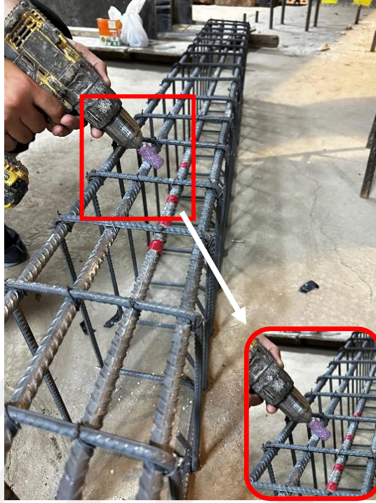
Şekil 4.7. Donatı taşlama işlemi.
