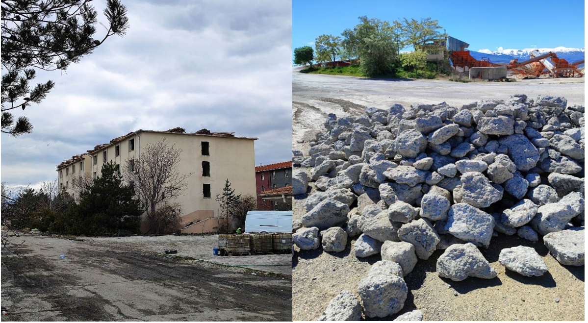
Şekil 6. Kamu binası ve yıkımdan elde edilen beton blokları
