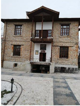
Şekil 4.46. Ağalar konağın ön cephesi (Anonim 49)
