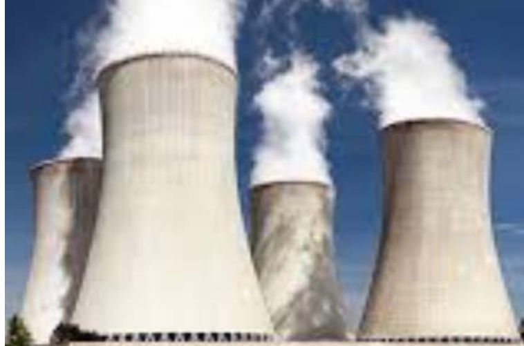
Şekil 3.1: Akışkanlar arasında doğrudan temasın olduğu ısı değiştiriciler.
