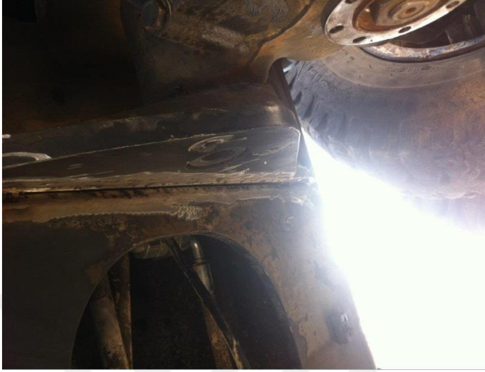
Şekil 3.18. İşlem yüzeyinin taşla temizlenmesi
