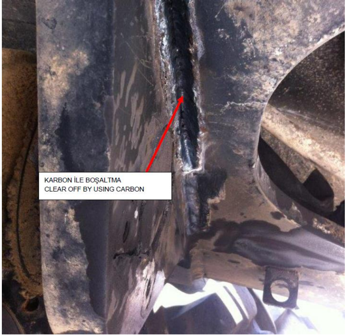
Şekil 3.17. Çatlağın karbon ile boşaltılması
