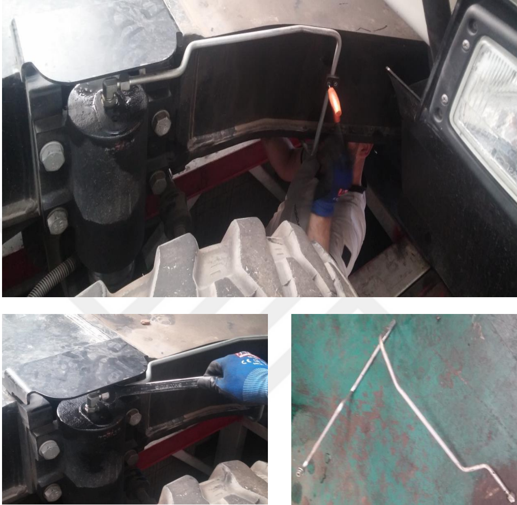
Şekil 3.16 Sağ-Sol Osilasyon Borularının sökümü
