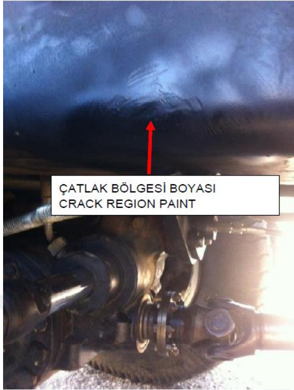
Şekil 3.20. Çatlak bölgesinin rötuş boya yapılması
