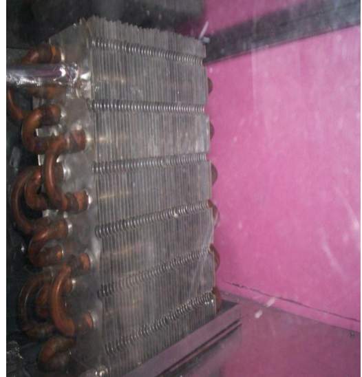
Şekil 1.7. Kurutma ünitesi nem alma serpantini
