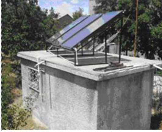
EK-12 Güneş destekli ısı pompalı sıcak hava üretim sisteminden görüntüler
