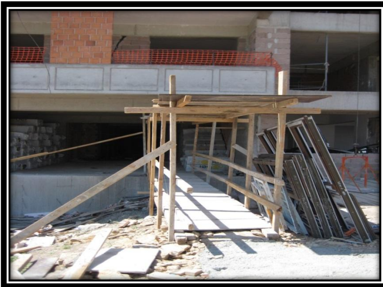
Resim 6.3.11- Yapı alanına giriş olumlu örnek
