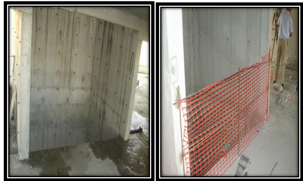
Resim 6.3.3- Asansör boşluğu olumsuz ve olumlu örnek
