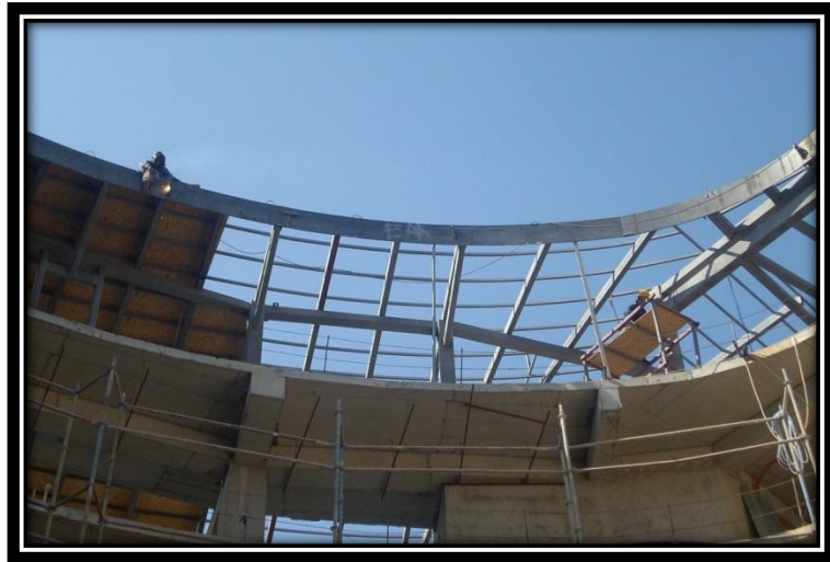
Resim 6.3.9- Emniyet kemeri ve yaşam halatı ile ilgili olumsuz örnek
