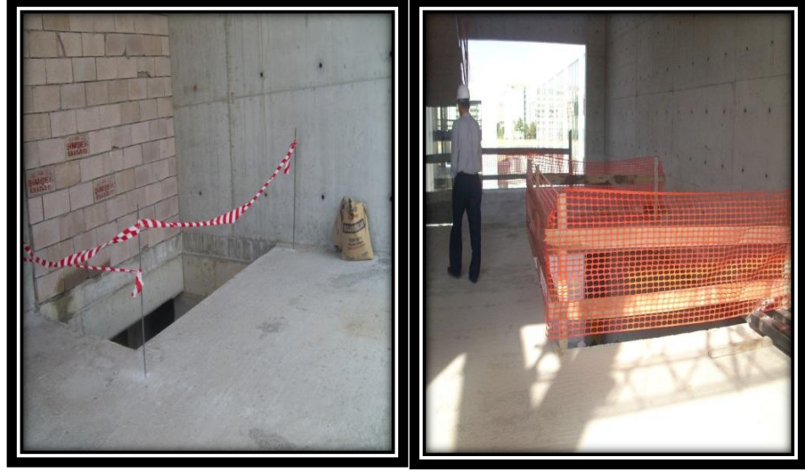
Resim 6.3.4- Zemin boşluğu olumsuz ve olumlu örnek
