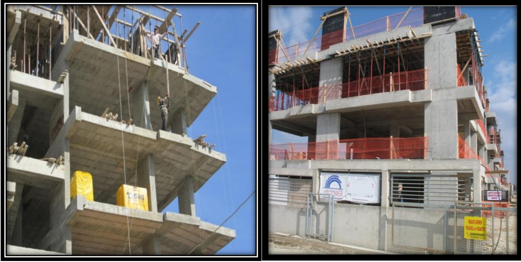
Resim 6.3.1-Kat platform kenarı olumsuz ve olumlu örnek
