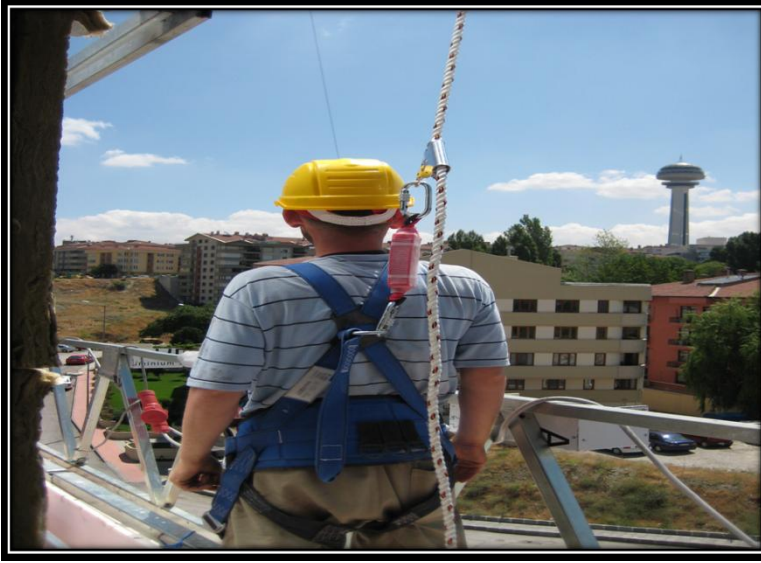
Resim 6.3.10- Emniyet kemeri ve yaşam halatı ile ilgili olumlu örnek
