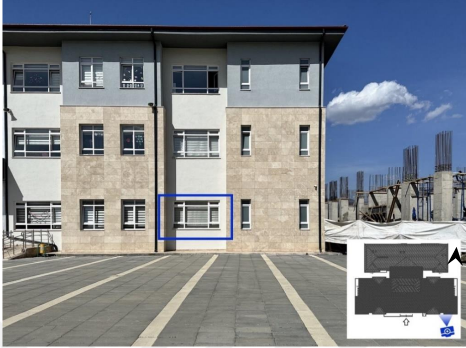
Şekil 5. 8. Güneydeki dersliğin dış cephe görünümü
