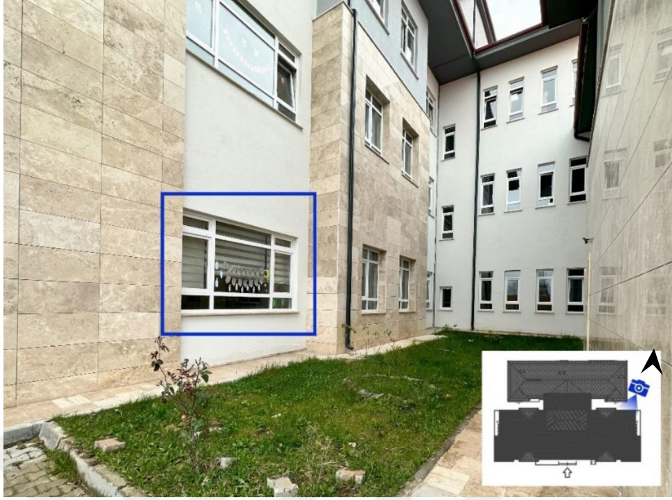
Şekil 5. 6. Kuzeydeki dersliğin dış cephe görünümü
