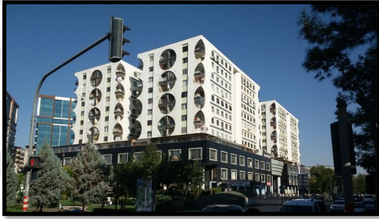
Şekil 4.6. Diyar Galeria AVM ve rezidans
