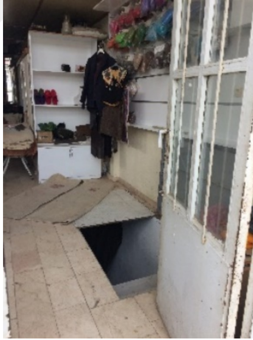
Görsel 3.1. Zemin Kat Depo Girişi (Mine Dağdeviren, 04.03.2019)
