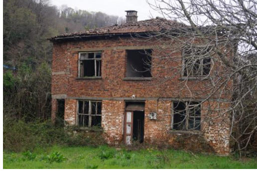
Şekil 123 Dereceki Köyünde Tamamen Tuğla Yığma Tekniğinin Kullanıldığı Eski Bir Ev
