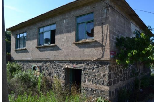
Şekil 127 Paşamandıra Köyünde Taş Duvar Üzerine İnşa Edilmiş Kerpiç Ev
