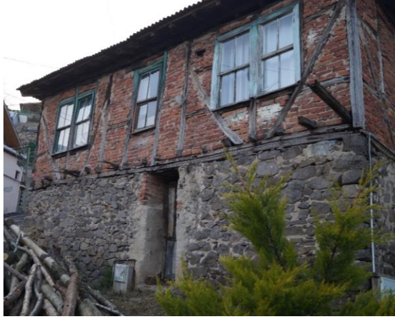
Şekil 117 Mahmutşevketpaşa’da Taş Temel Üzerine Tuğla Dolgulu Ahşap Çatki Tekniği ile İnşa Edilmiş Bir Ev
