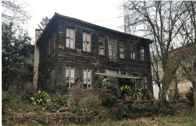
Şekil 2 Akbaba Köyünde Bulunan Malakof Hasan Paşa Konağı
