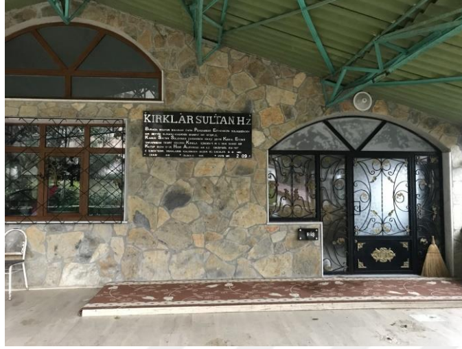
Şekil 95 Kırklar Sultan Türbesinin Dışarıdan Görünüşü
