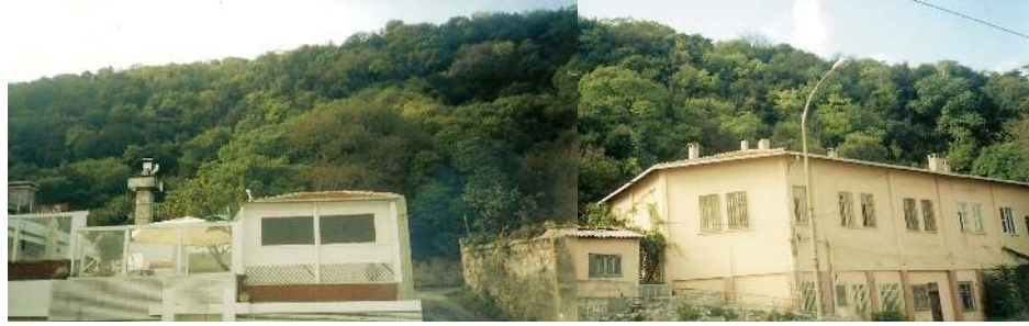
Şekil 5.8 Vakıf Korusunun Arnavutköy-Kuruçeşme sahil yolundan girişi
