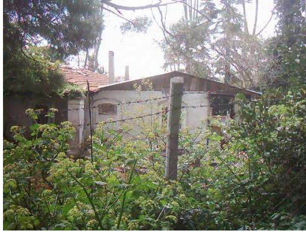
Şekil 5.69 Koru içerisinde bulunan izinsiz yapı (Eyüpreisoğlu, 2006)
