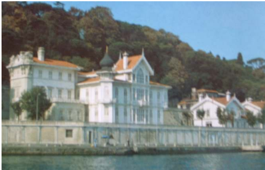
Şekil 5.80 Huber Köşkünün Boğaziçinden görünüşü
