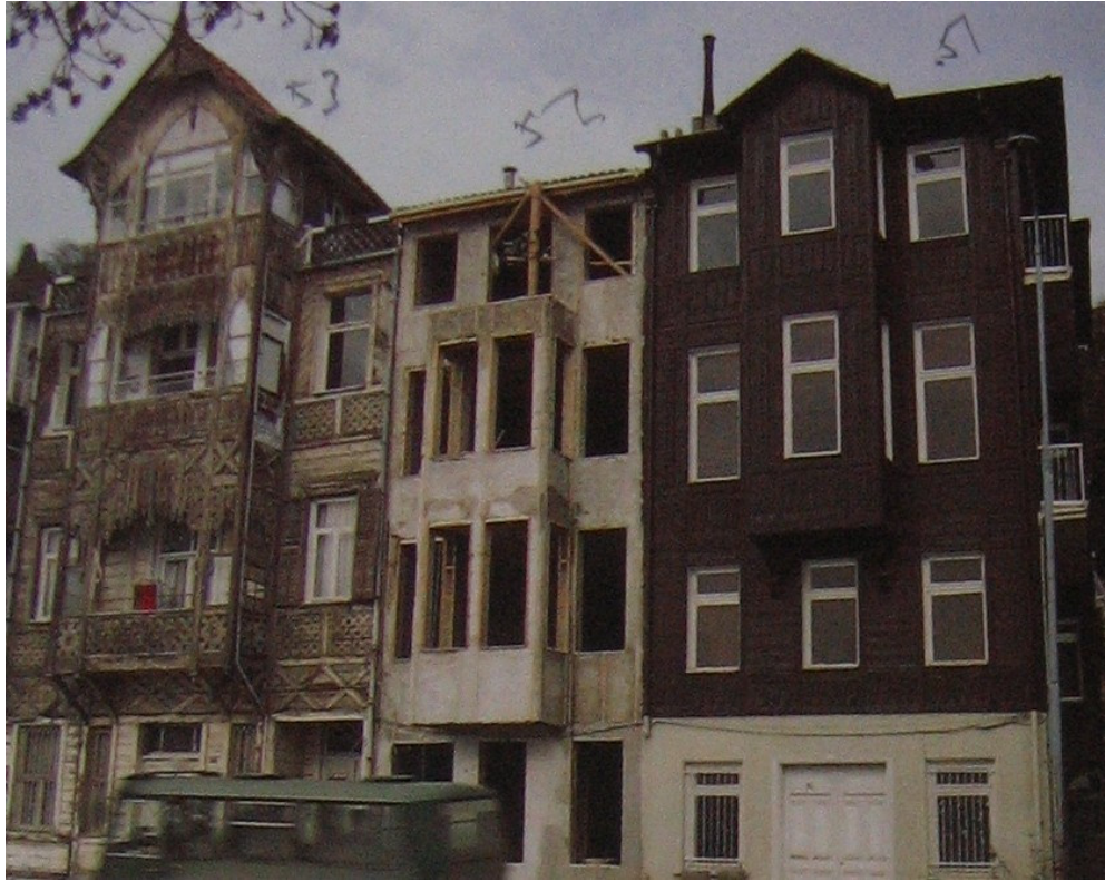
Resim 2.12. Büyükdere’de betonarme sistemle rekonstrüksiyonu yapılan yapılar [27]
