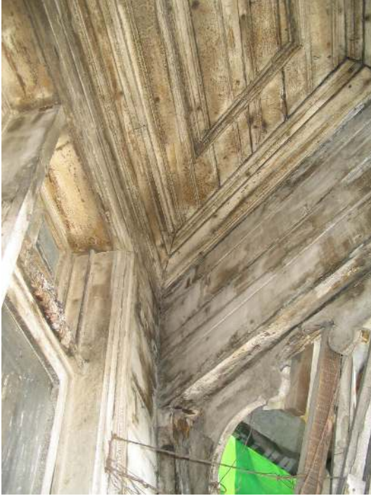
Resim 1.72. Balkondaki malzeme deformasyonu
