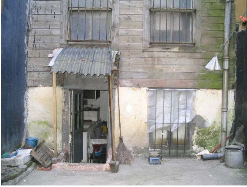
Resim 1.23. Zemin kat arka cephe
