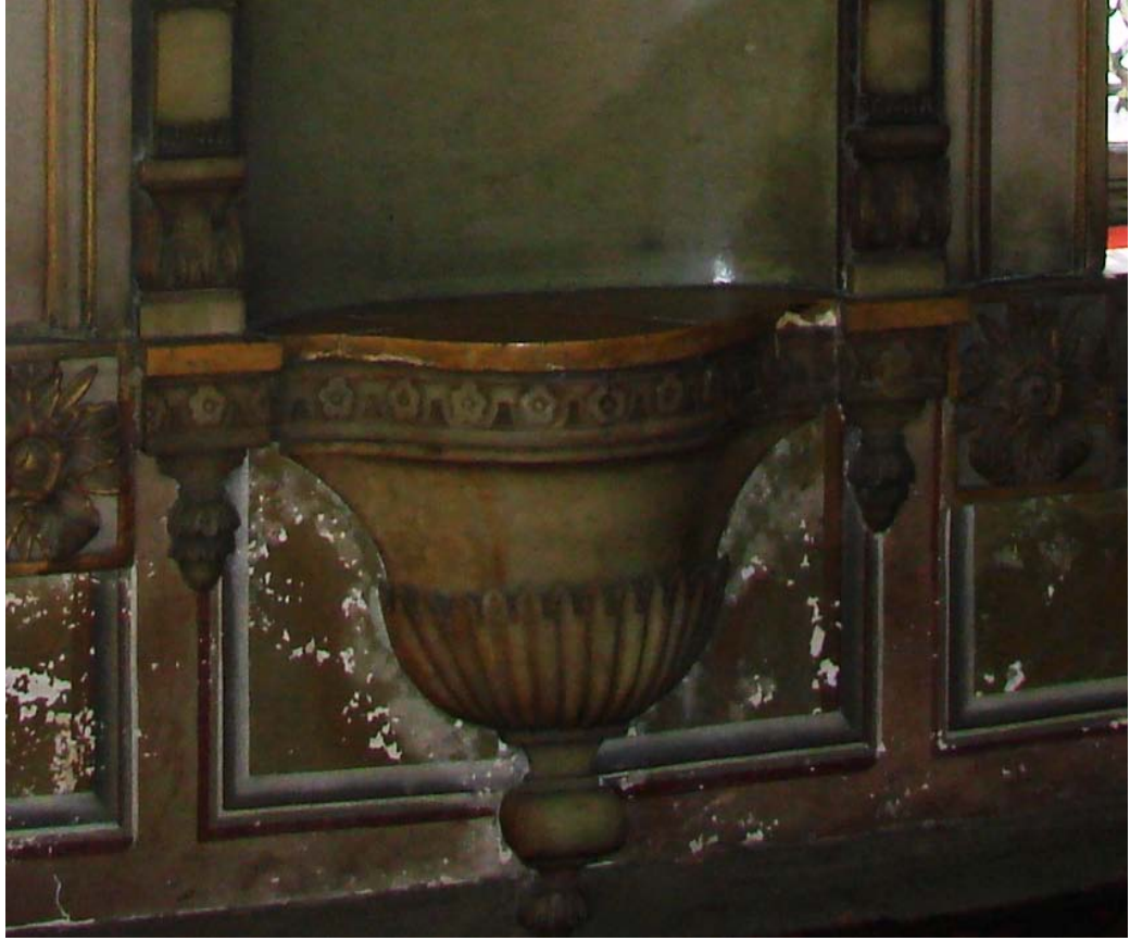
Fotoğraf – 66. Hünkâr Mahfili Doğu Duvar
