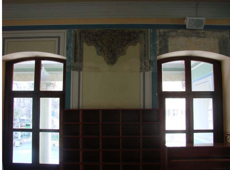
Fotoğraf-219. Hünkâr Yapısı Üst Kat Duvar
