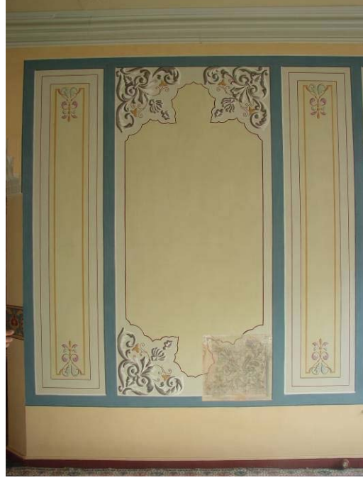
Fotoğraf-222. Hünkâr Yapısı Üst Kat Duvar
