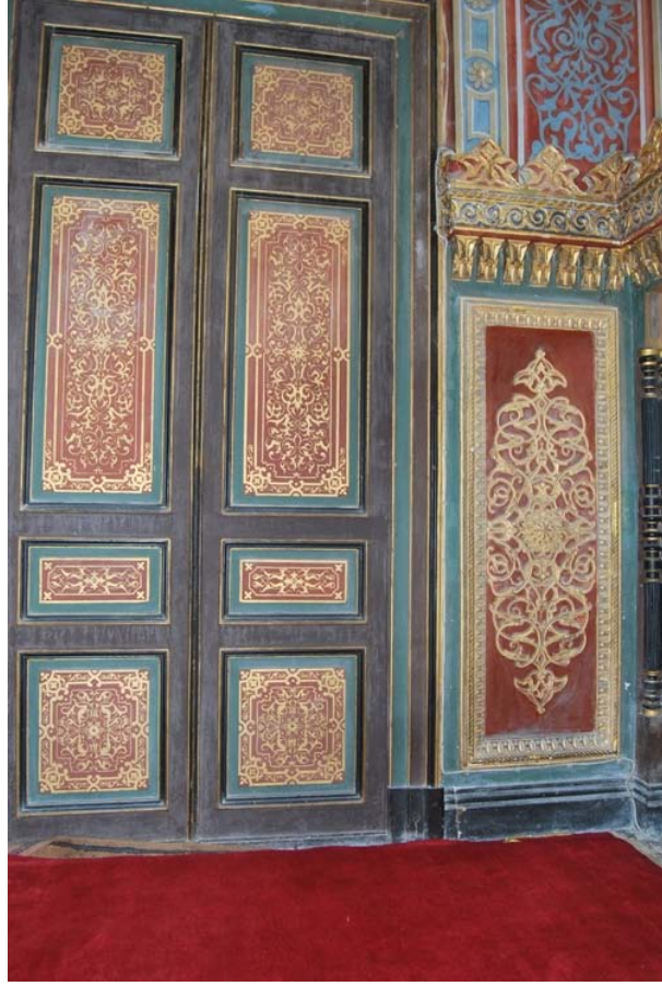
Fotoğraf- 241. Son Cemaat Yeri Üzeri Ahşap Bölümdeki Kapılar
