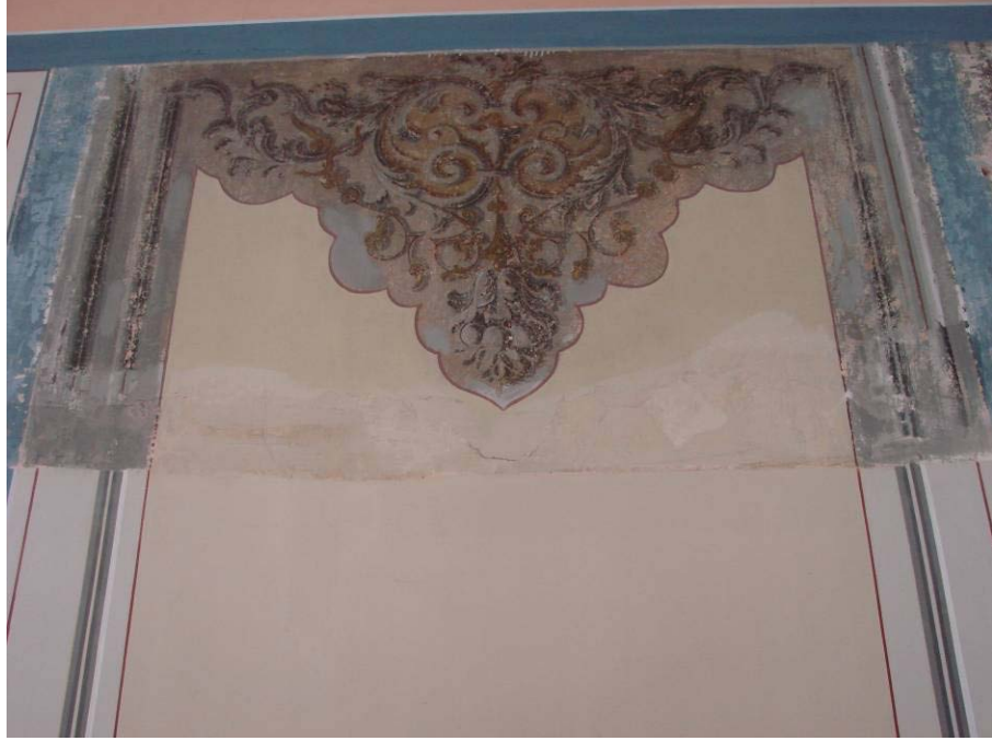
Fotoğraf–220. Hünkâr Yapısı Üst Kat Duvar
