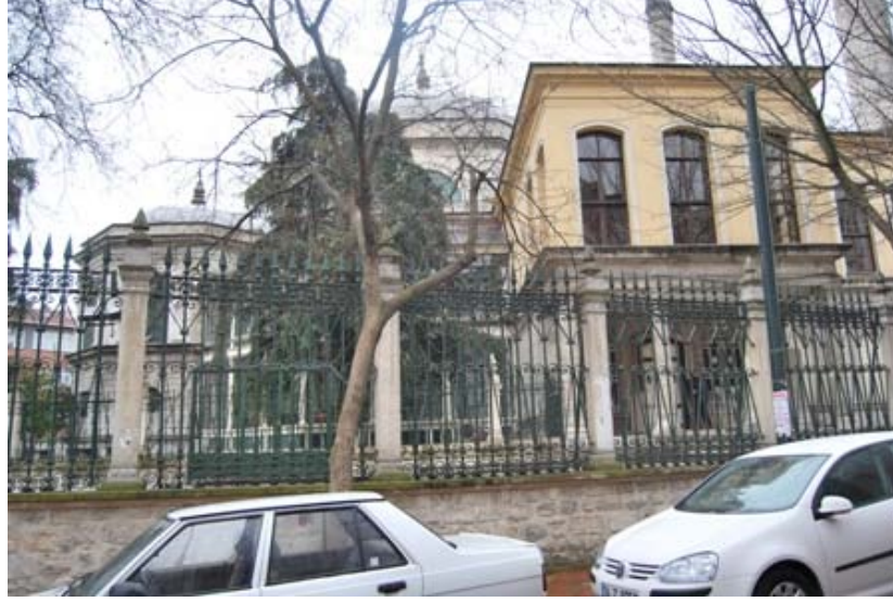
Fotoğraf–138. Batı Cephe
