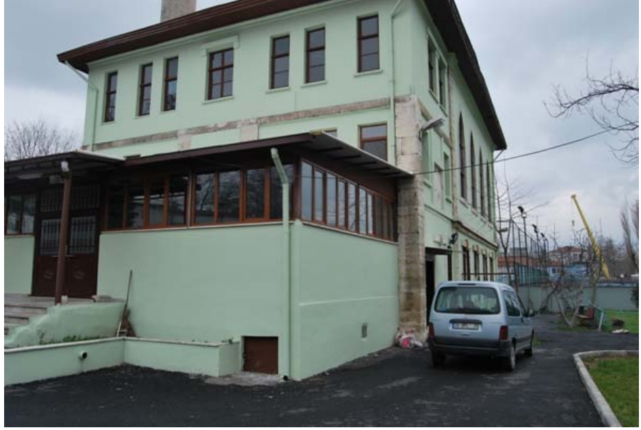
Fotoğraf-200. Çorlulu Ali Paşa Camii Genel Güney Cephe
