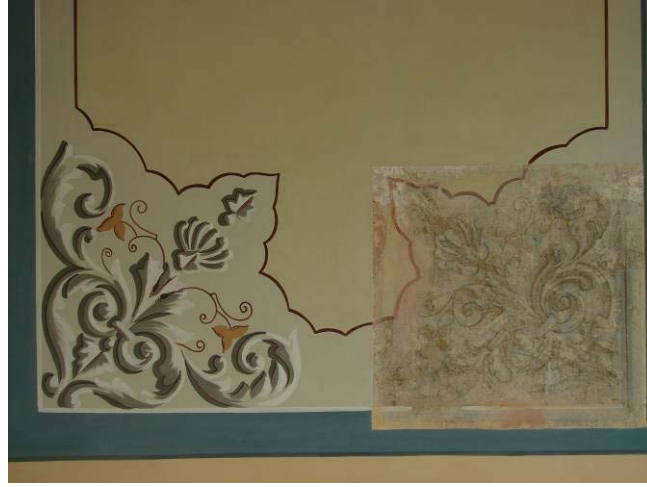
Fotoğraf-223. Hünkâr Yapısı Üst Kat Duvar
