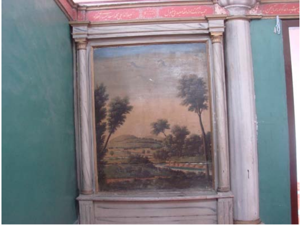
Fotoğraf – 14. Hünkâr Mahfili Kuzey Duvar
