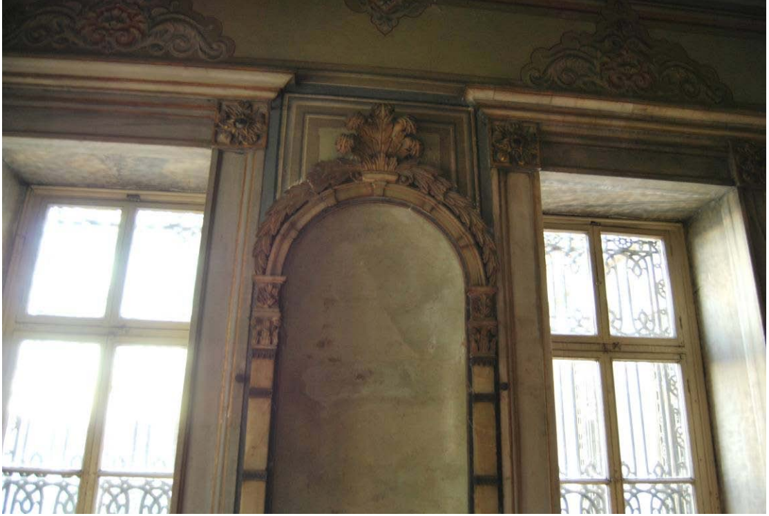
Fotoğraf – 67. Hünkâr Mahfili Doğu Duvar
