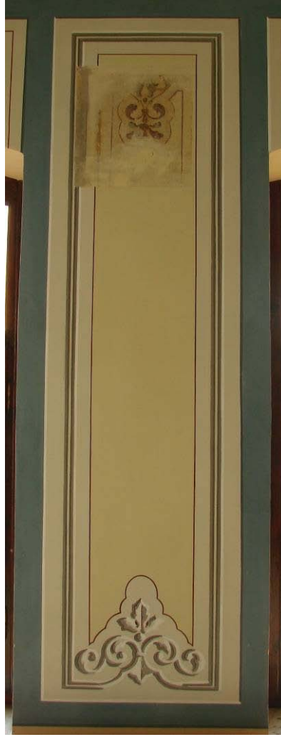
Fotoğraf-221. Hünkâr Yapısı Üst Kat Duvar
