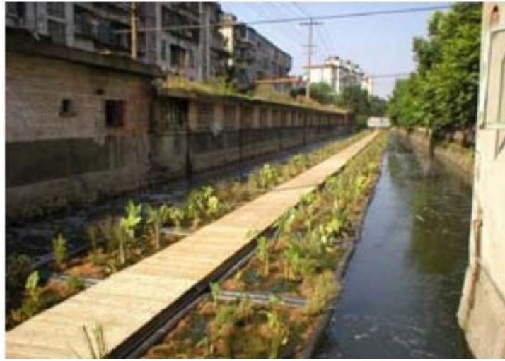
Şekil-28 Suyu Temizlemek İçin Tasarlanmış Yüzen Ekosistem (Oceans, 2007)
