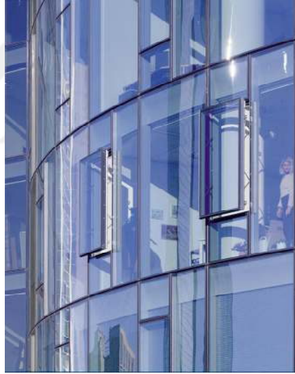
Şekil-49 Main Tower Binasının Açılabilir Pencereleeri (Url-27)
