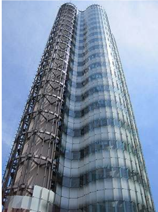
Şekil-66 Maslak No1 Ofis Binası Cephesi (Url-37)
