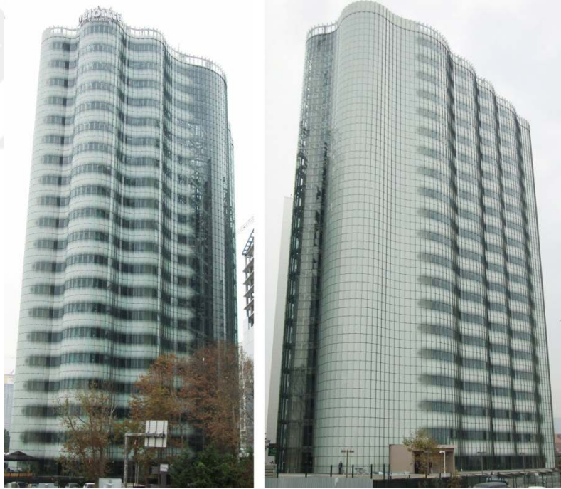
Şekil-69 Maslak No1 Ofis Binası Cephesi (Url-38)
