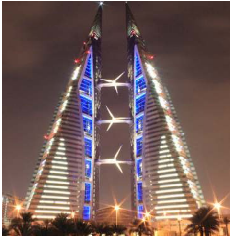
Şekil-16 Yapıya Entegre Edilmiş Rüzgar Tribünleri (Esin, Yüksek, 2009, sf.4)
