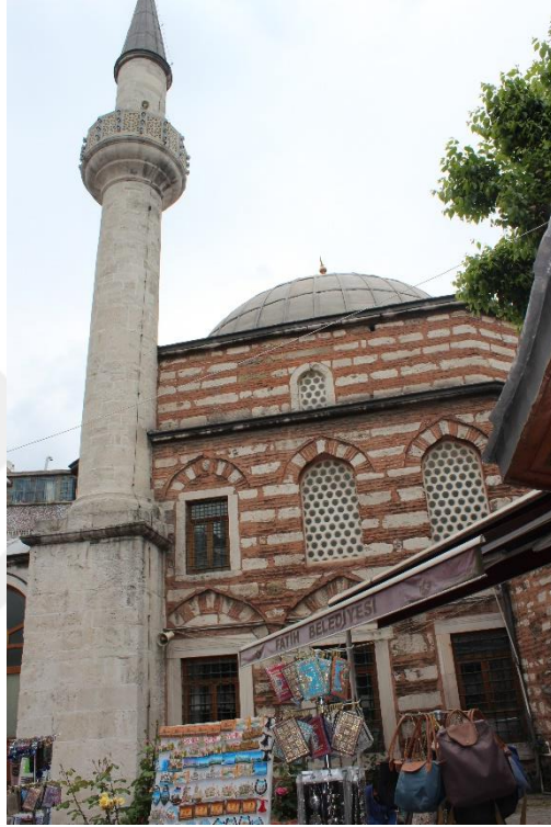
Fotoğrad 3.1 Cami Doğu Cephe.
