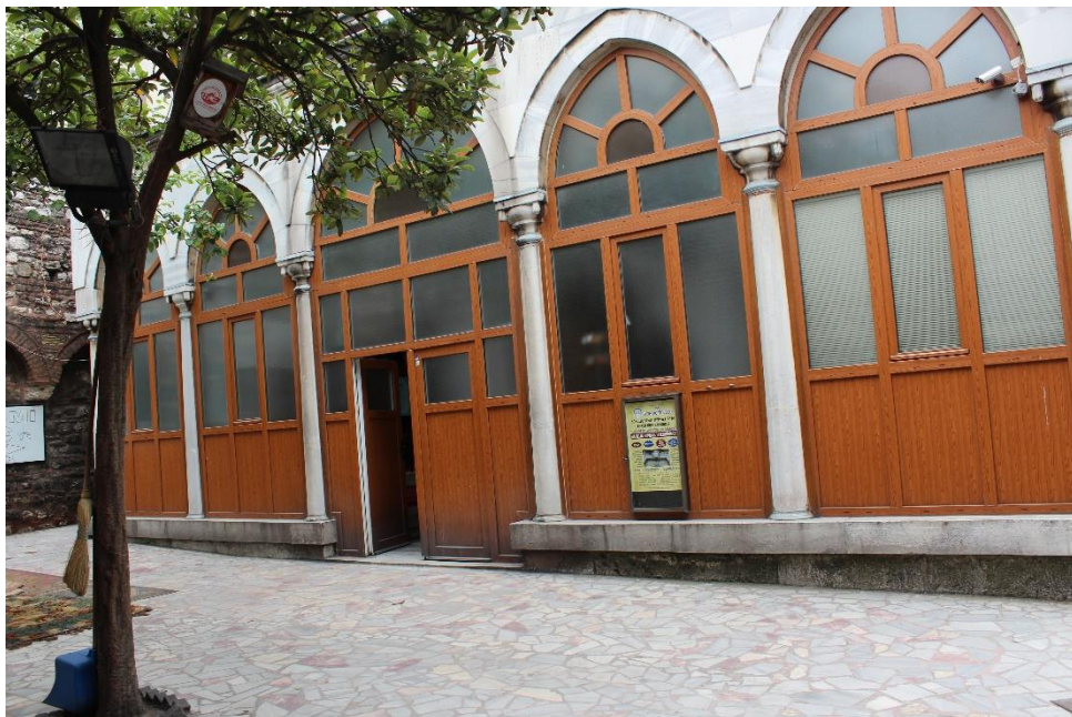
Fotoğraf 3.2 Cami Güney Cephe.
