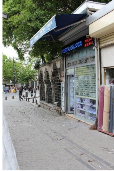
Fotoğraf 3.9 Kütüphane'nin Güney Cepheden Görünüşü.
