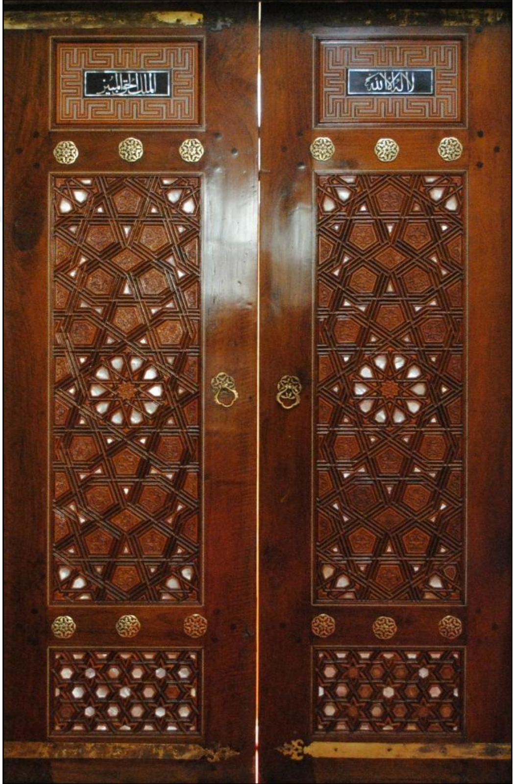
Resim 2.5. Atik Valide Sultan Camii pencere iç kepenği kanatları
