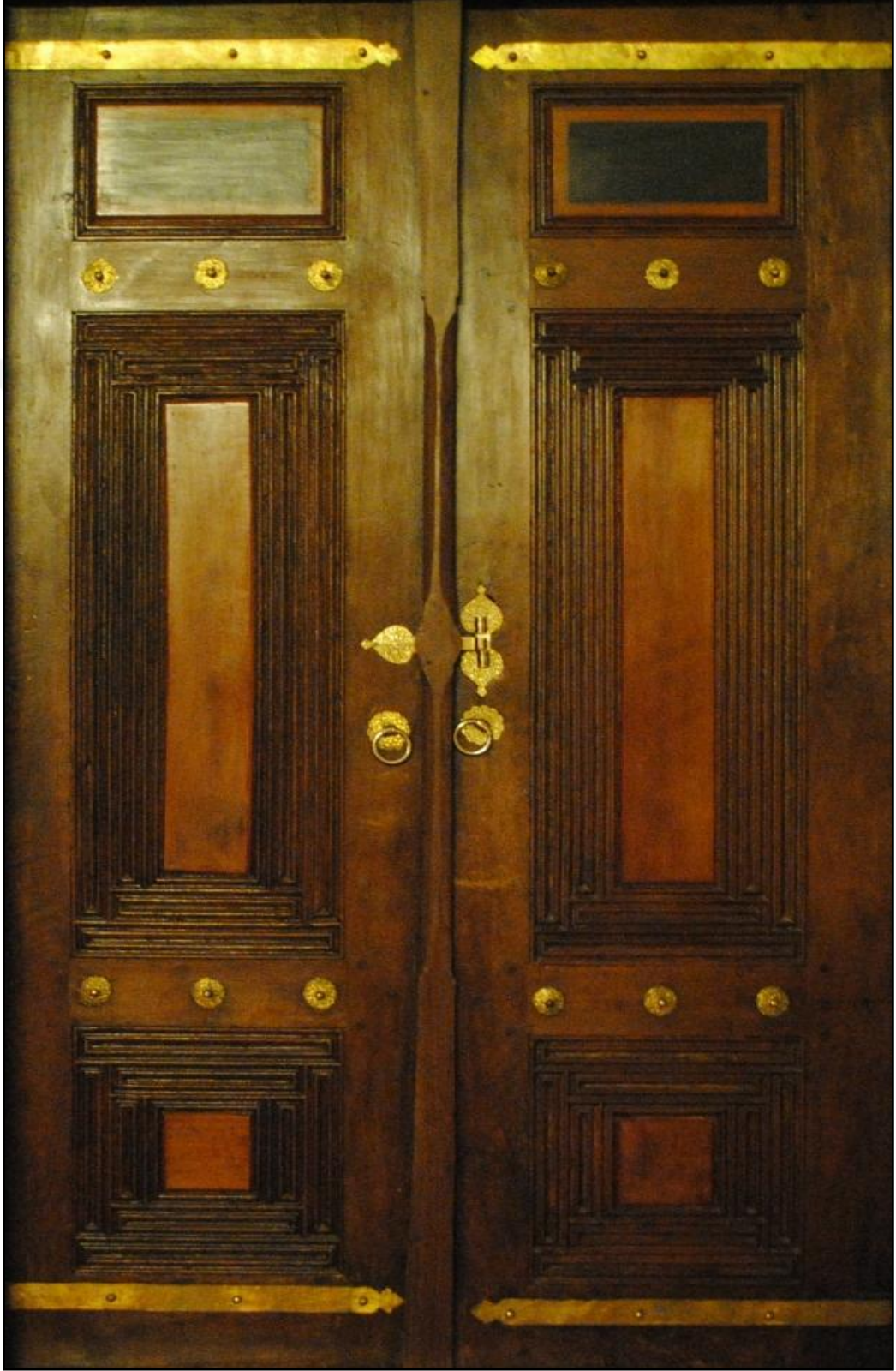
Resim 2.8. Sinan Paşa Camii pencere iç kepengi kanatları
