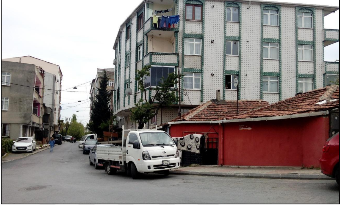
Foto 15: Çifte Havuzlar Mahallesi'ndeki Çarpık Kentleşmeden Bir Görünüm, 2015
