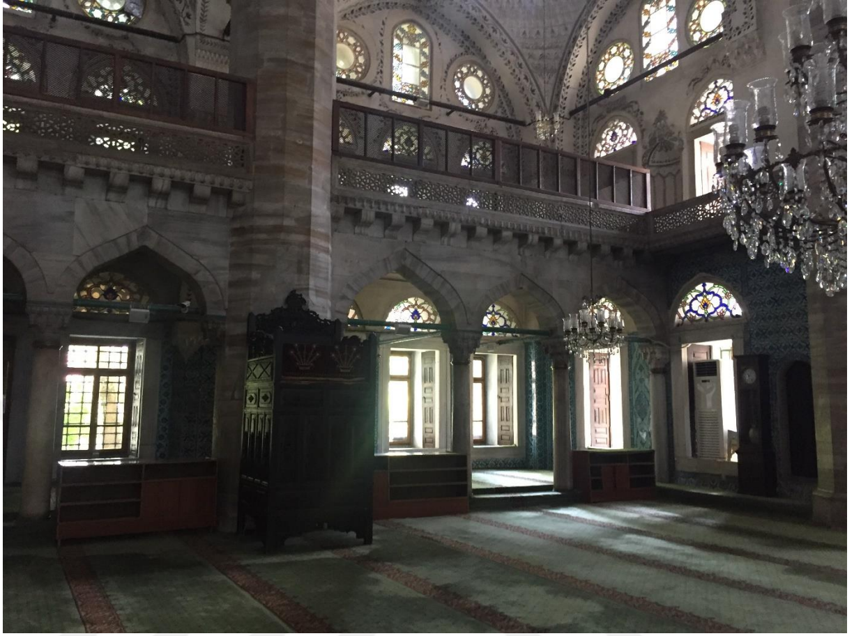
Resim:5.27. Doğu duvarı
