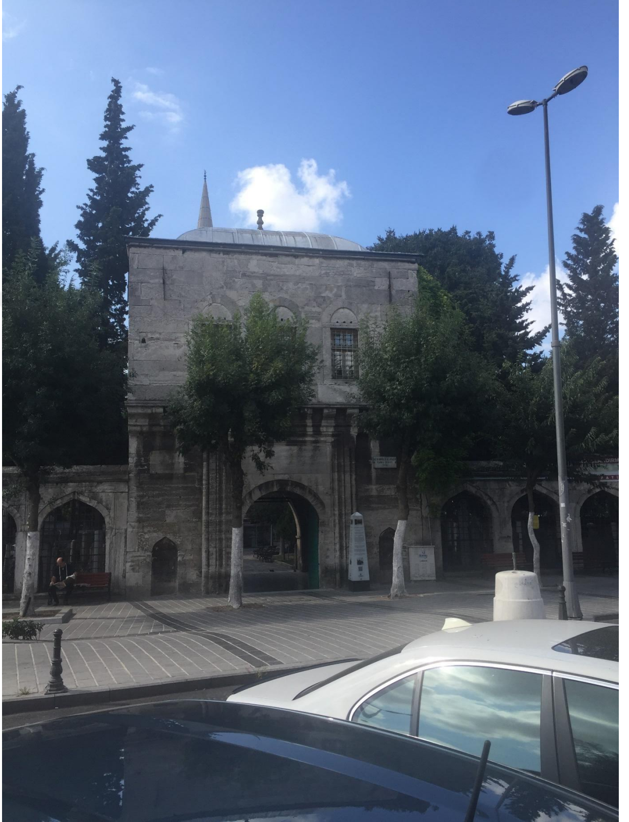
Resim: 5.49. Kütüphane, cadde cephesi
