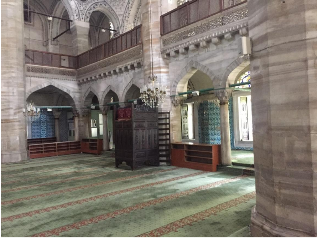
Resim:5.21. Doğu duvarı genel görünüm
