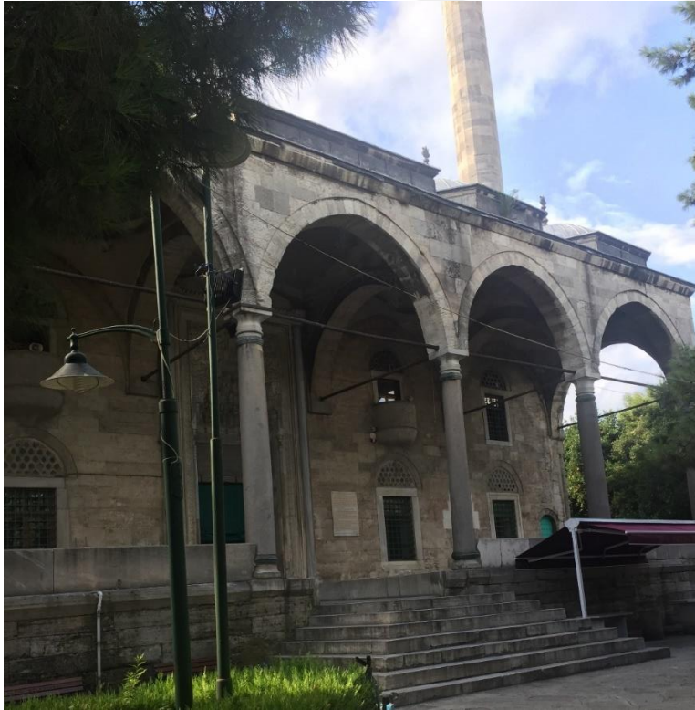
Resim: 5.13. Cami, kuzey cephe
