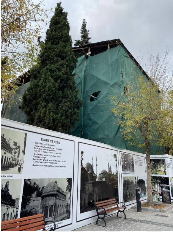
Resim: 5.74. Restorasyon çalışmaları sırasında kütüphane binası, kuzey cephe
