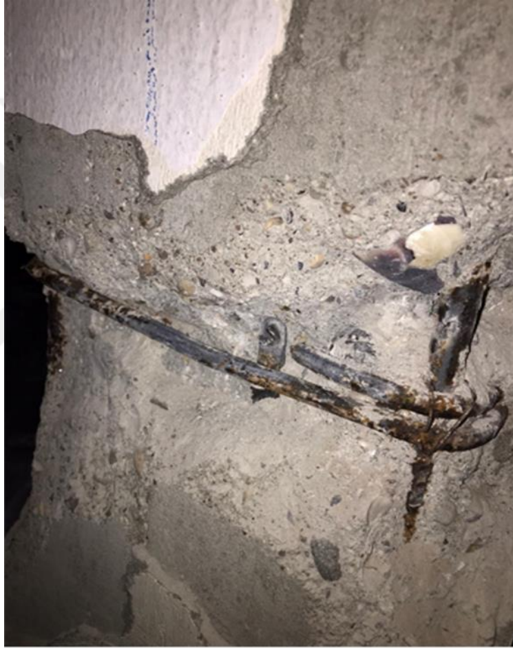
Resim 3.2. Sıyırma işlemi yapılan kolon
