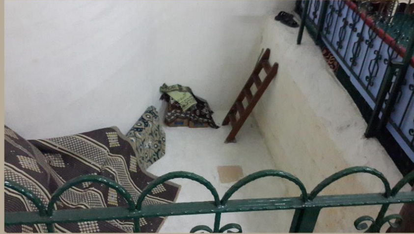
Şekil 4.46.B. Kambur Mustafa Paşa Camii Altındaki Sarnıç Yapının Özgün Yüksekliği ve Minare Boşluğu (Yıldırım Arşivi)
