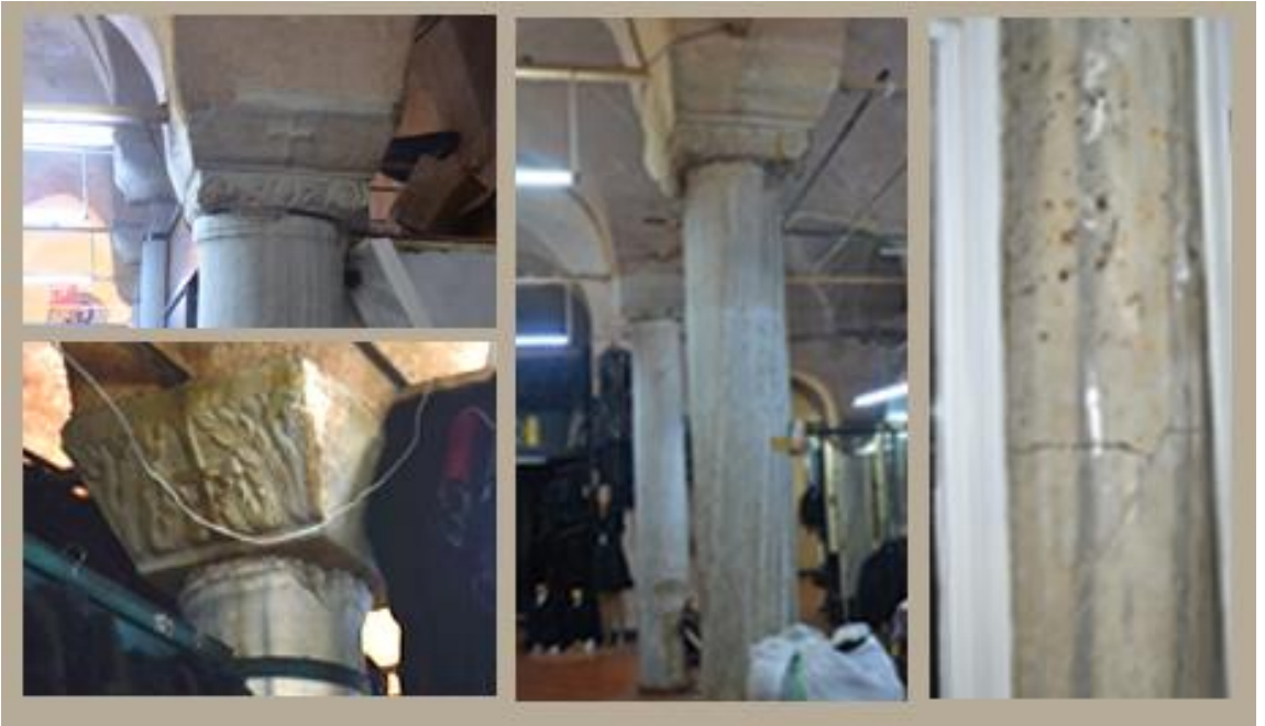
Şekil 4.24. Myrelaion Sarnıcı Özgün Yüzey Elemanlarındaki Deformasyonlar (Yıldırım Arşivi)
