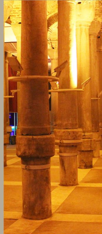
Şekil 3.14.E. Binbirdirek Sarnıcı Parçalı Sütun Görünümü (Yıldırım Arşivi)
