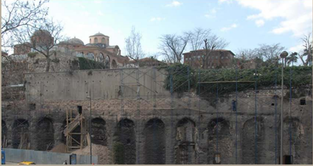
Şekil 3.13.A. Zeyrek Sarnıcı Dış Duvar (Payanda) Görseli (Yıldırım Arşivi)
