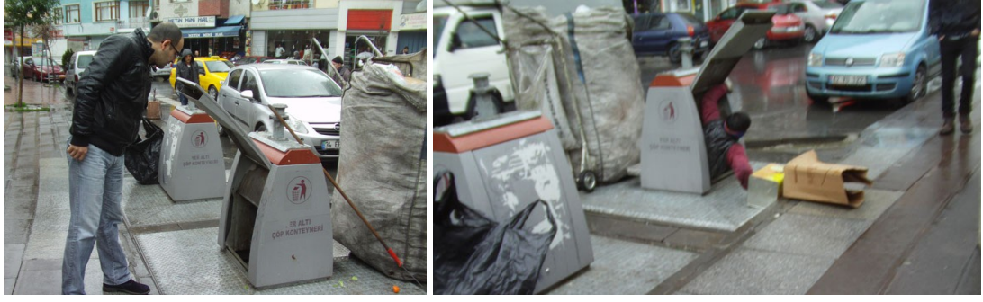
Şekil 4.31: Fatih Belediyesi yeraltı çöp konteynırı ve içindeki çöp toplayıcı (fotoğraf: Url-2).
