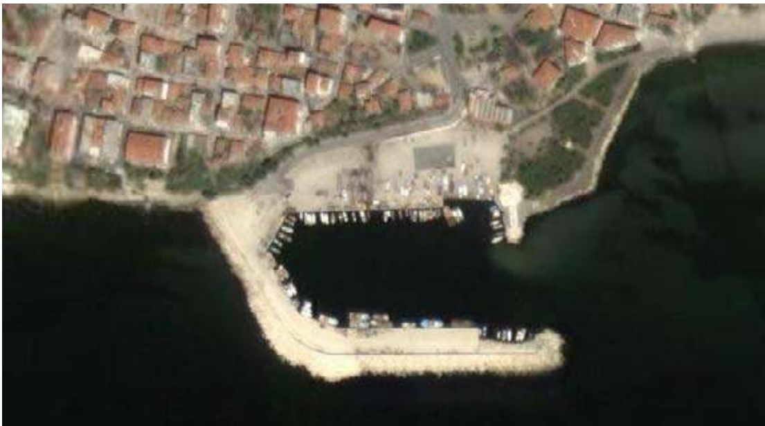
Şekil 6.29 Silivri Selimpaşa Balıkçı Barınağı görünüşü (www.googleearth.com)
