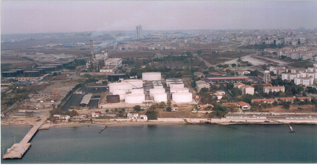
“Şekil 6.11” Kiyı gerisi dolum tesisi.
