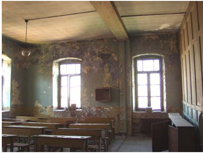
Şekil 6.66 104 sınıf mekanının üzeri sıvalı volta döşeme tavanı.
