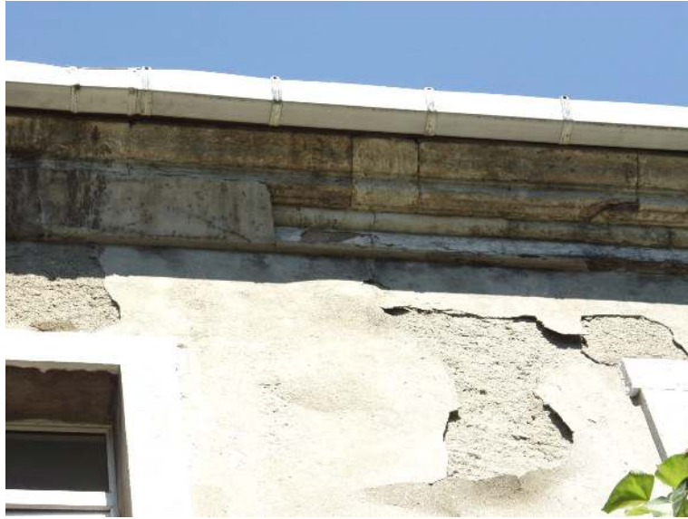
Şekil 6.88 Saçak altı taş silme.
