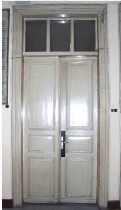
Şekil 6.18 Z01 Sınıf mekanı ahşap giriş kapısı.
