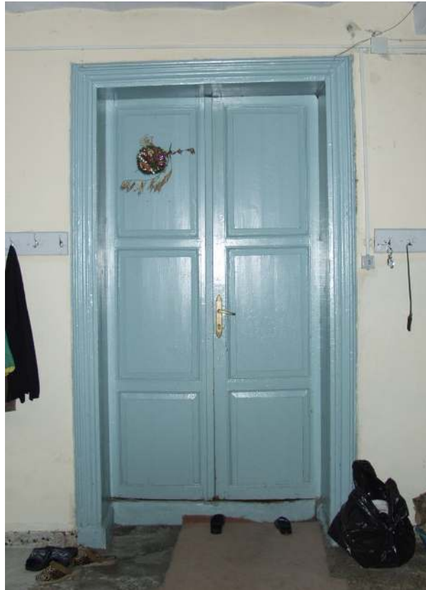
Şekil 6.5 B07 Mekanı, özgün ahşap giriş kapısı.
