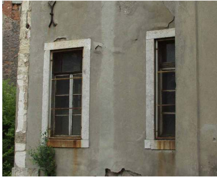
Şekil 6.86 Zemin kat metal kafesli pencereler.
