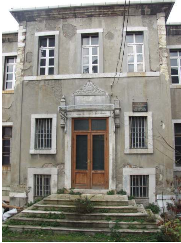
Şekil 6.79 Güneybatı (Giriş) Cephesi.
