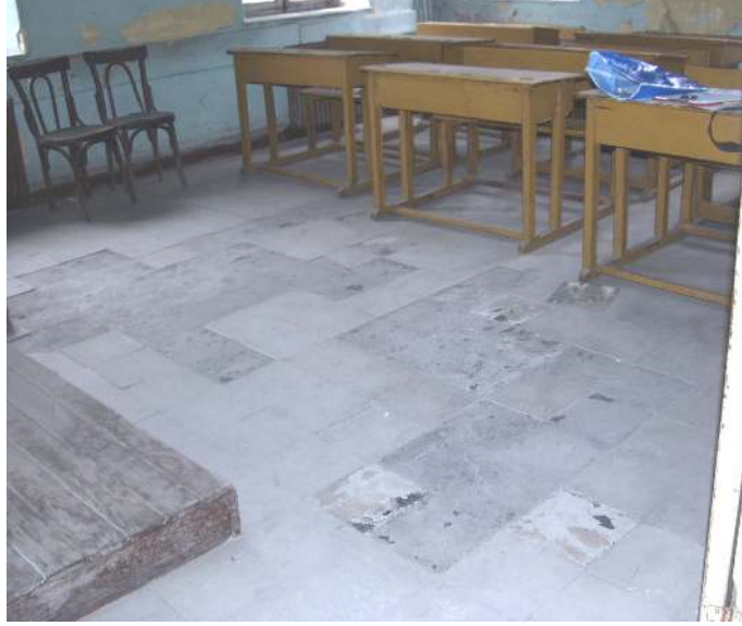
Şekil 6.19 Z01 Mekanı döşeme kaplaması.
