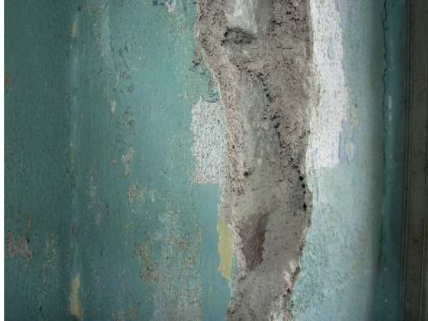
Şekil 6.22 Mekanın köşe noktalarının taş malzemesi.
