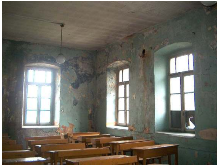
Şekil 6.56 102 Mekanı ahşap pencereleri ve koltuk silmesi.
