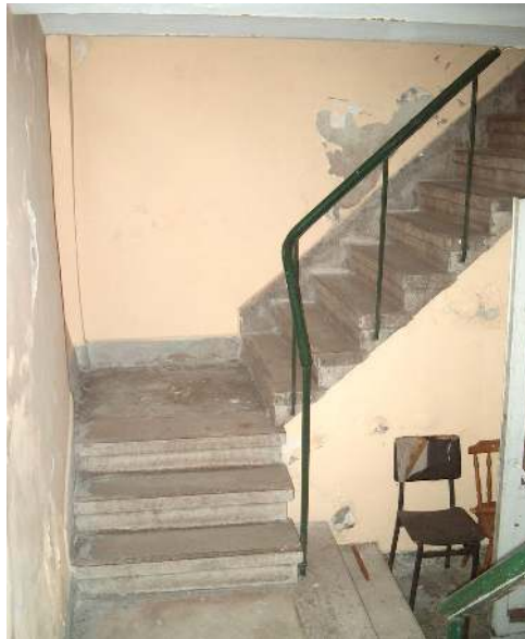
Şekil 6.14 Bodrum kat mozaik merdiven
