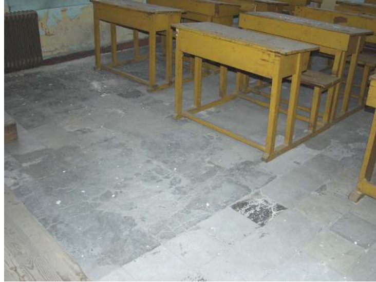
Şekil 6.52 101 mekânı pvc karo döşeme kaplaması.
