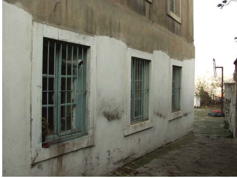
Şekil 6.101 Bodrum kat demir parmaklıklı ahşap pencereler.
