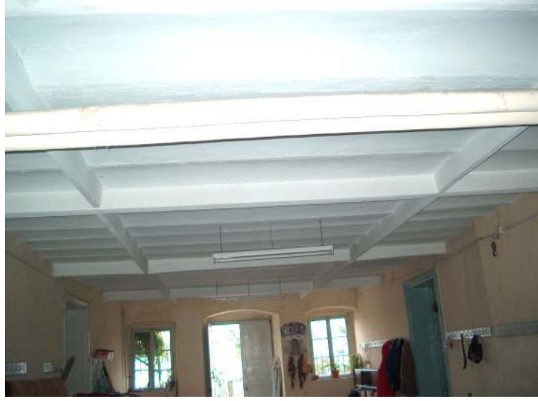
Şekil 6.11 B14 Hol Mekanı, çelik kirişli volta döşeme.
