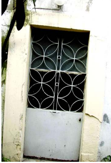
Şekil 6.95 Bodrum kat metal giriş kapısı.
