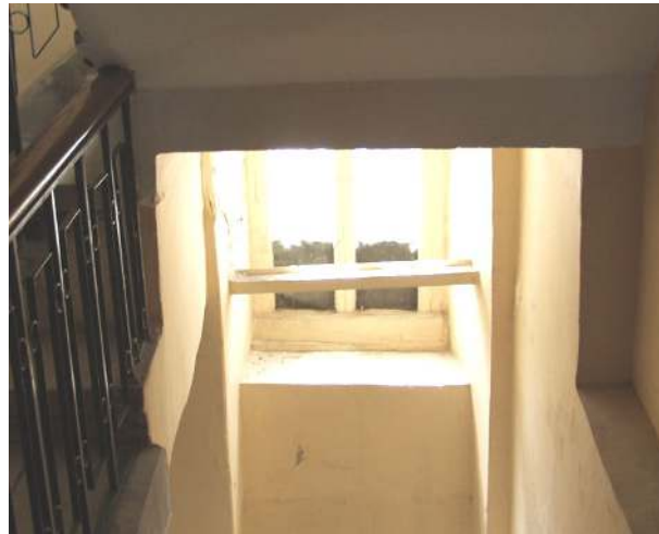
Şekil 6.16 Bodrum Kat Merdiven Holü Sağ Pencere
