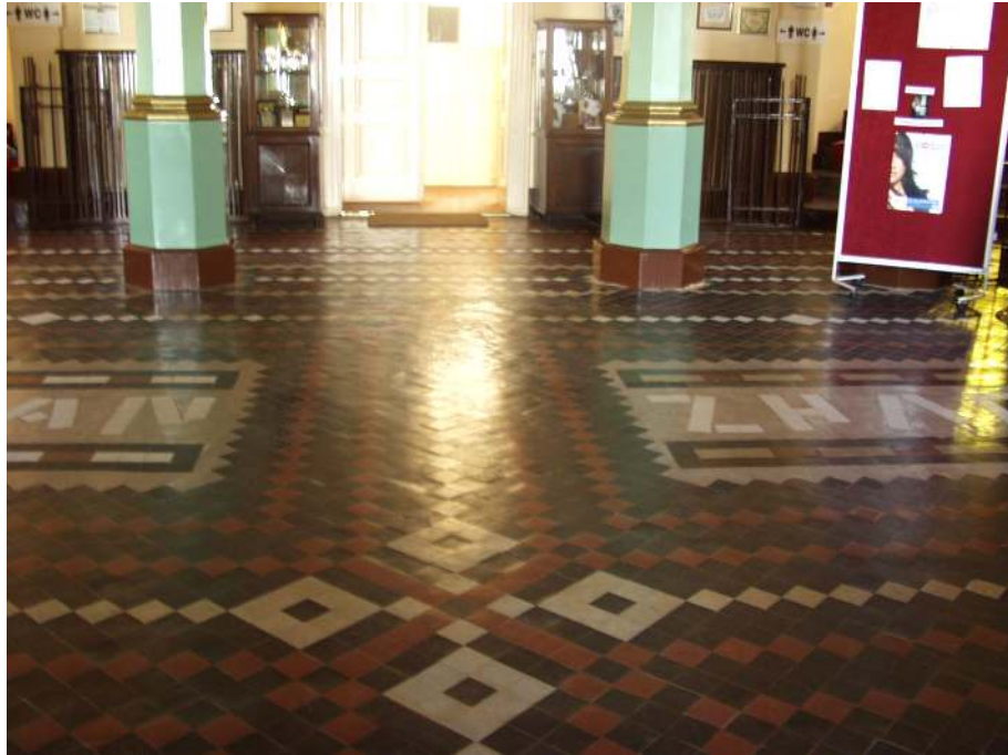
Şekil Ek 3. 2 Giriş holü özgün döşeme kaplaması.
