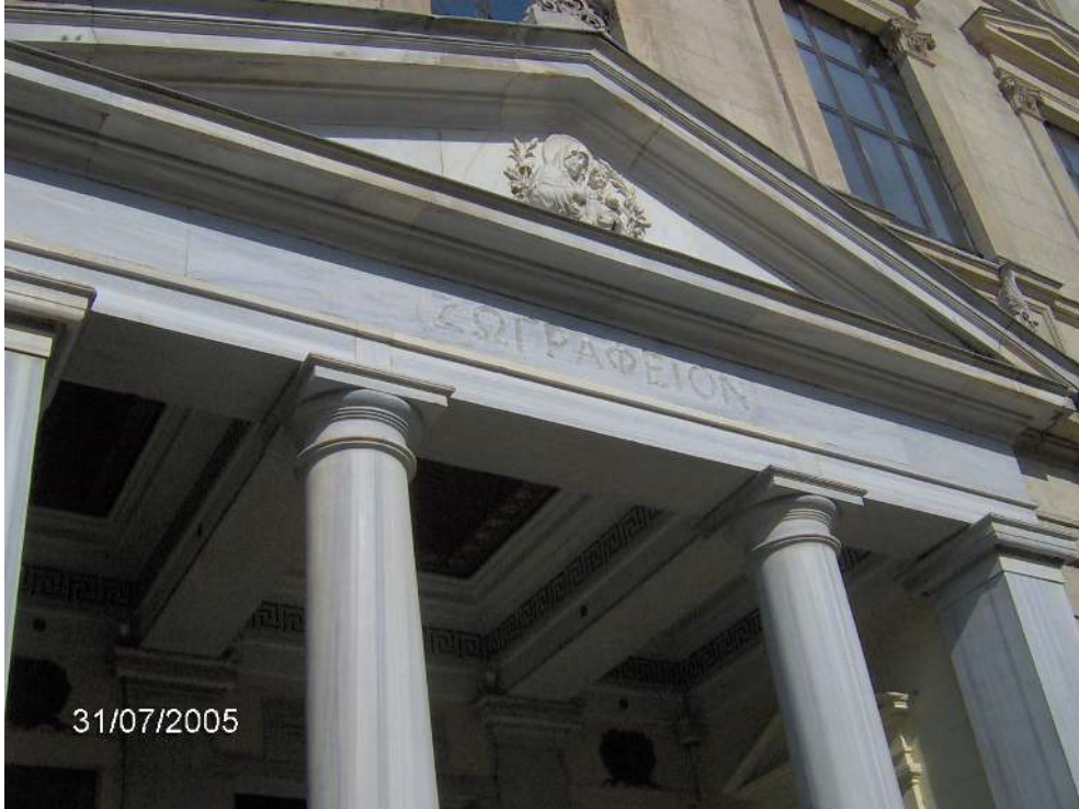
Şekil 4.46 Giriş Cephesi, üçgen alınlık.
