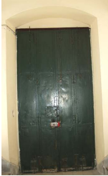
Şekil 6.46 Binanın metal ana giriş kapısı.
