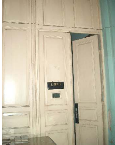
Şekil 6.54 102 sınıf mekânına girişi sağlayan ahşap bölme ve kapı.
