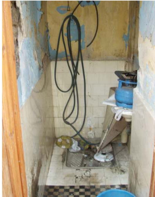
Şekil 6.3 B03 Wc mekanı.
