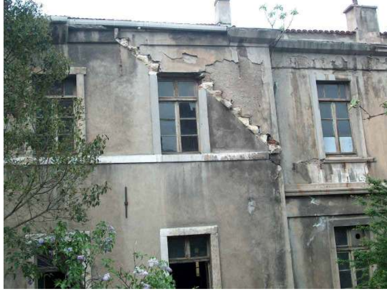
Şekil 6.99 Güneydoğu Cephesinde yer alan muhdes merdiven izi.
