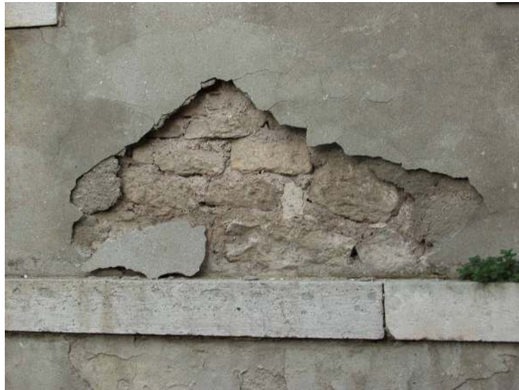
Şekil 6.90 Raspa sonucu ortaya çıkan örgü düzeni.
