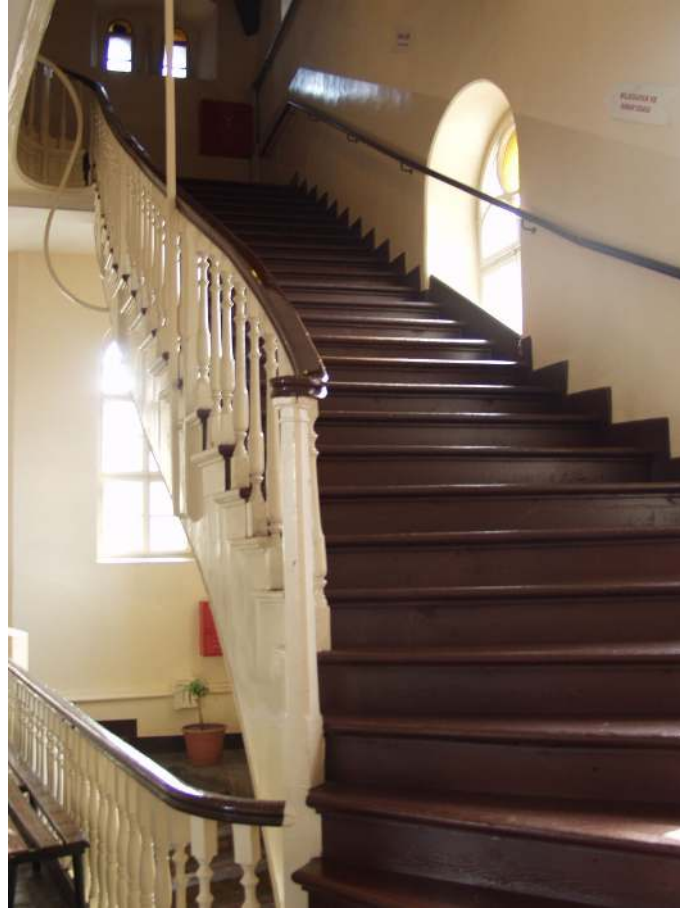
Şekil Ek 3. 4 Ahşap merdivenler.
