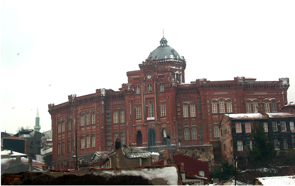
Şekil 4.19 Fener Rum Erkek Lisesi'nden genel görünüş.
