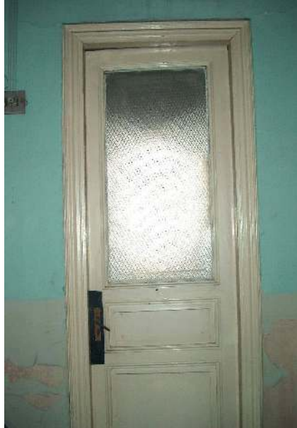
Şekil 6.71 106 sınıf mekanının tek kanatlı ahşap giriş kapısı.
