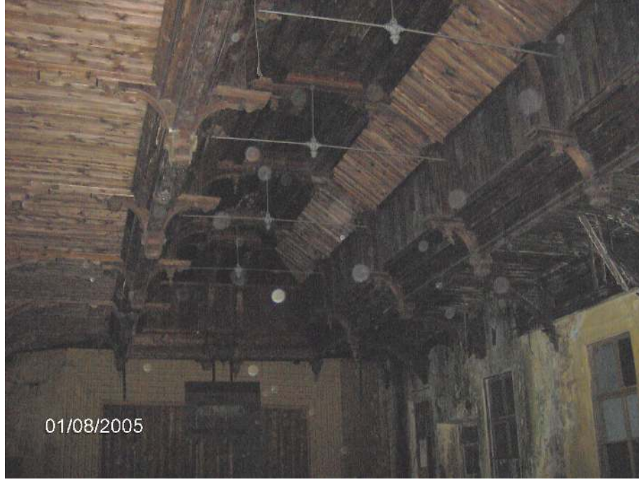
Şekil 4.10 Jimnastikhanenin tavanı, ahşap payandalar.
