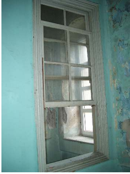
Şekil 6.70 106 revir mekanının muhdes ahşap giyotin penceresi.
