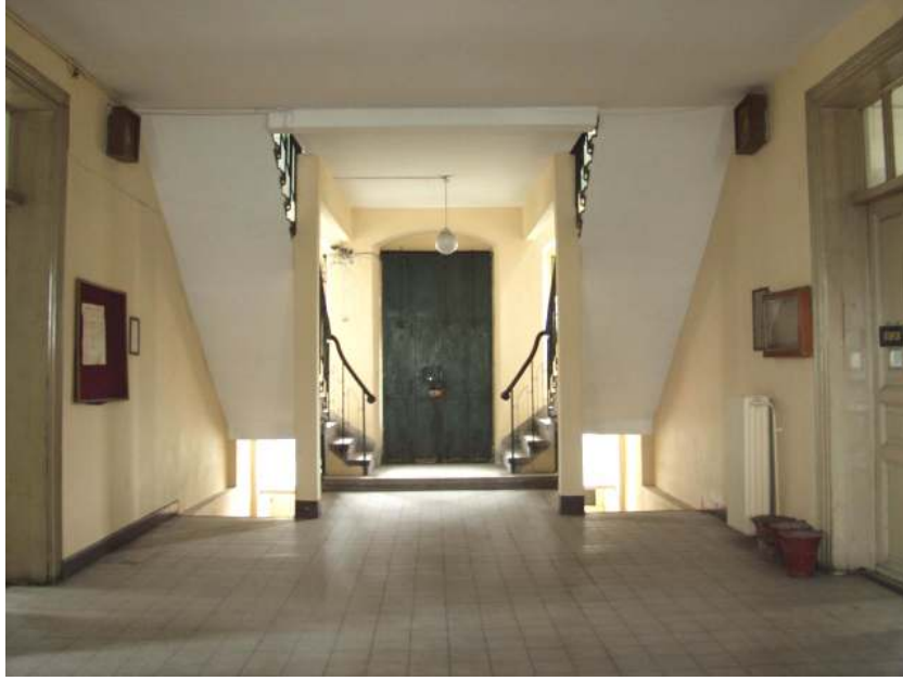
Şekil 6.44 Katlara ulaşımı sağlayan üç kollu mozaik merdiven.
