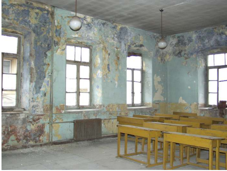
Şekil 6.65 Mekanın Kuzeybatı Cephesi'ne bakan ahşap pencereleri.
