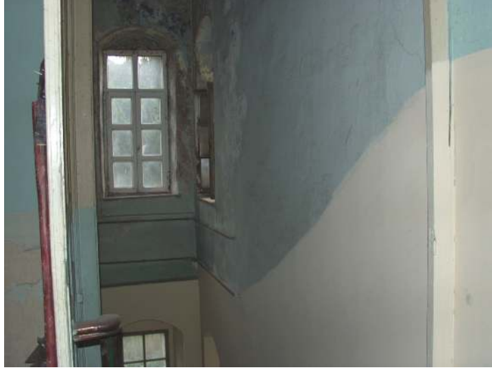
Şekil 6.77 Merdiven holünün pvc pencereleri.
