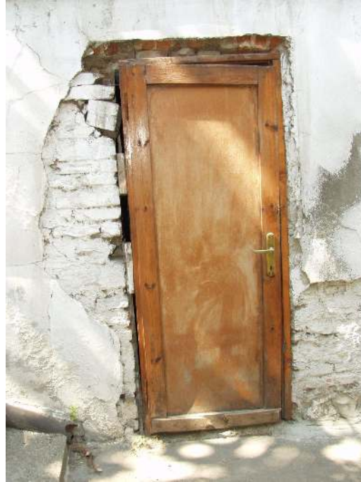
Şekil 6.96 Bodrum kat muhdes wc mekanının ahşap kapısı
