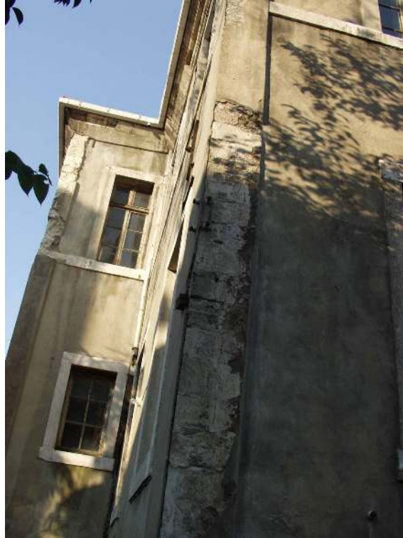
Şekil 6.98 Güneydoğu Cephesinin taş köşe noktaları.
