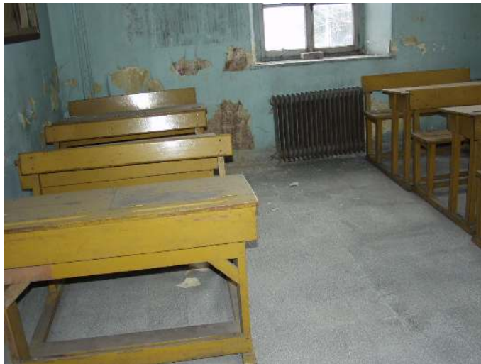
Şekil 6.26 Z03 Mekanı döşeme ve duvar kaplaması.
