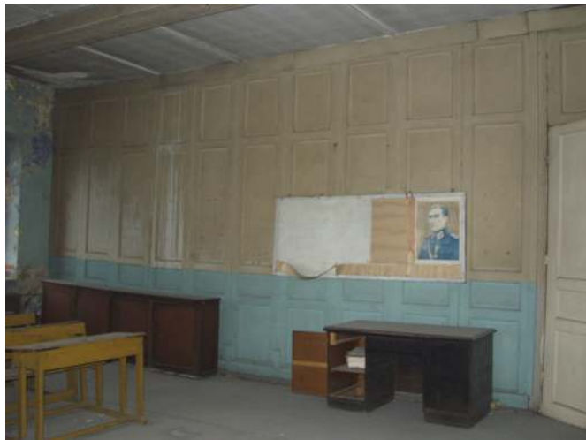
Şekil 6.60 104 sınıf mekanını holden ayıran muhdes ahşap bölme.
