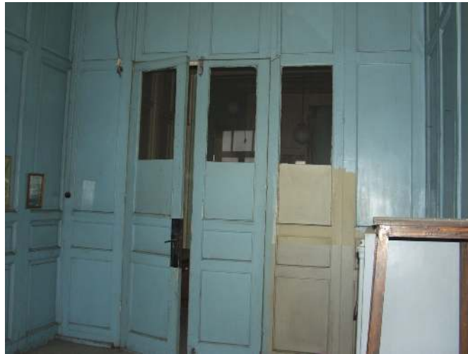
Şekil 6.58 103 Müdür odasını holden ayıran ahşap bölme.
