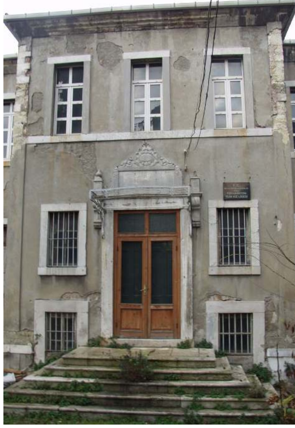
Şekil 4.26 Güneybatı (giriş) Cephesi, taş ve sıvalı yüzeyler.
