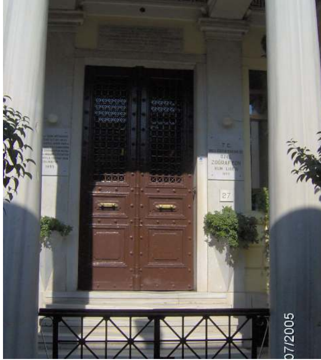
Şekil 4.47 Özgün metal giriş kapısı ve plastrlar.
