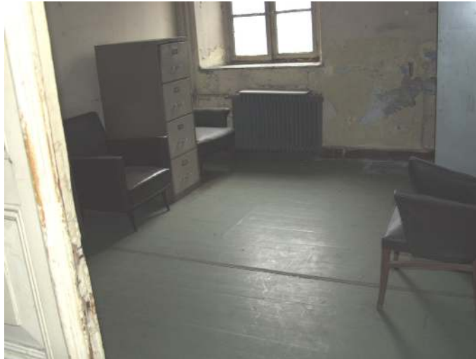
Şekil 6.24 Z02 Mekanının ahşap üzeri linolyum kaplaması.
