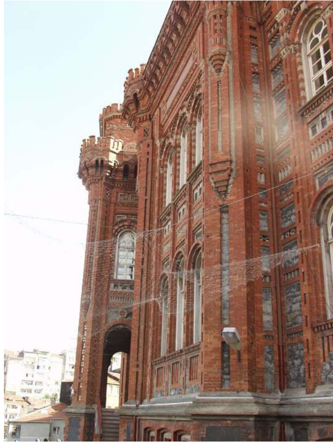
Şekil Ek 3. 6 Giriş Cephesi.
