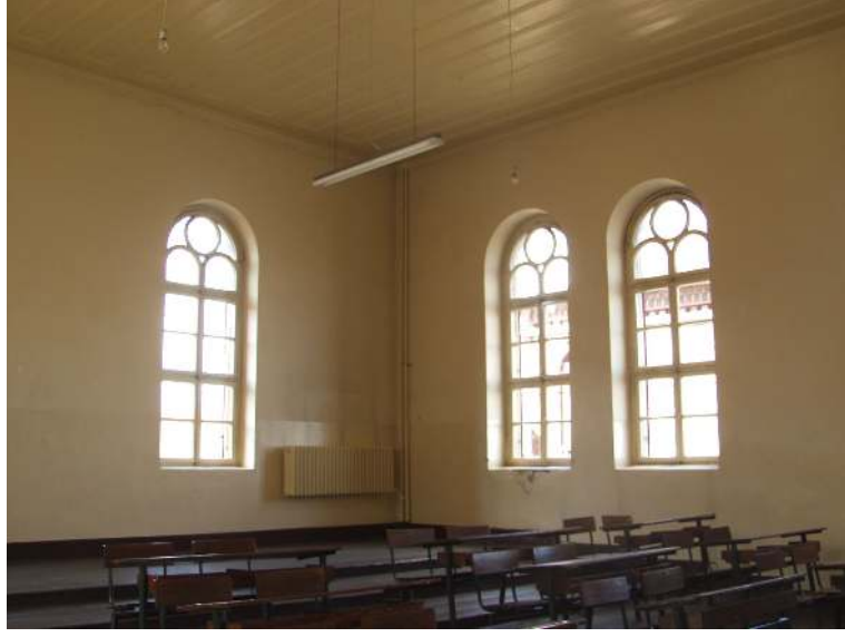
Şekil 4.20 Özgün ahşap pencereler
