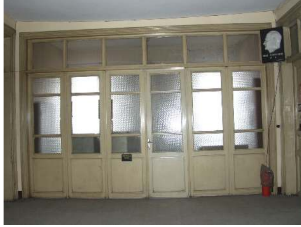
Şekil 6.27 Z04 Mekanını ana holden ayıran ahşap bölme.
