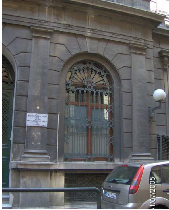
Şekil 4.36 Taş izlenimi veren sıvalı yüzey, plastrlar.
