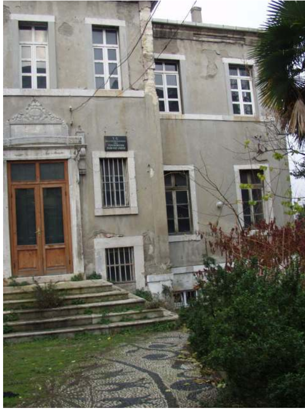
Şekil 6.80 Güneybatı (Giriş) Cephesi.
