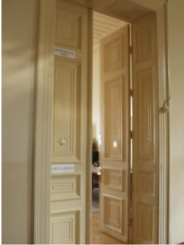
Şekil 4.21 Özgün ahşap iç kapılardan bir örnek.
