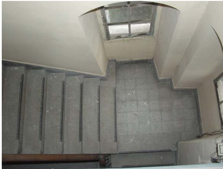
Şekil 6.74 Mozaik merdiven ve ahşap küpeşte.
