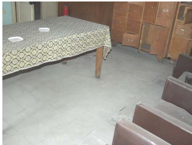
Şekil 6.32 Z05 Mekanı pvc karo döşeme kaplaması.
