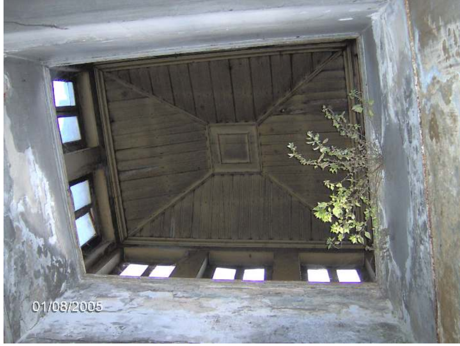
Şekil Ek 2. 3 Kule tavan kaplaması.
