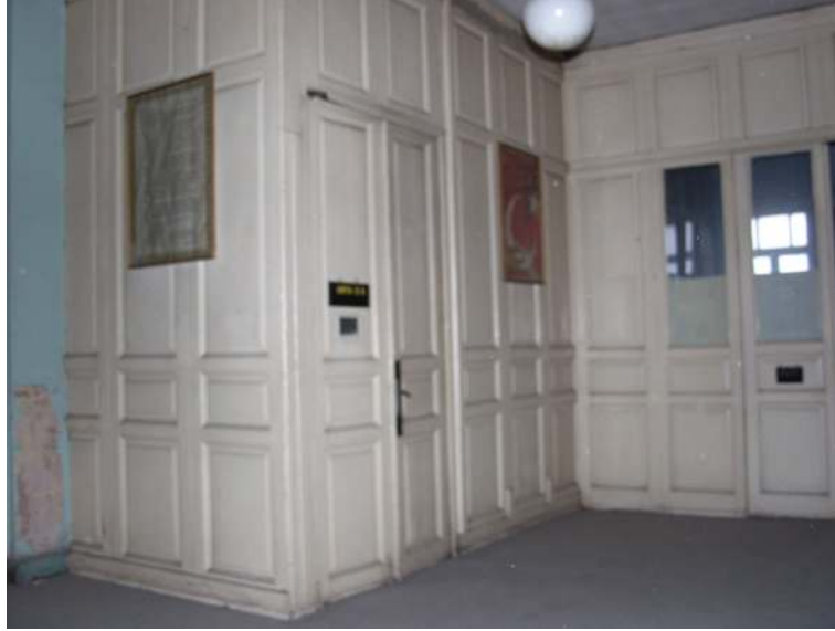
Şekil 6.62 104 sınıf mekanını holden ayıran muhdes ahşap bölme.
