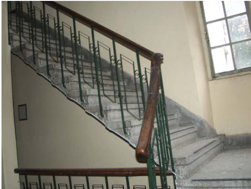
Şekil 6.45 Merdivenin ahşap küpeşte ve demir korkulukları.
