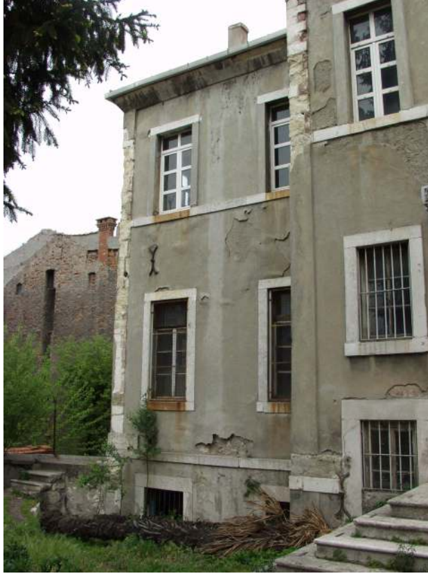
Şekil 6.81 Güneybatı (giriş) Cephesi.
