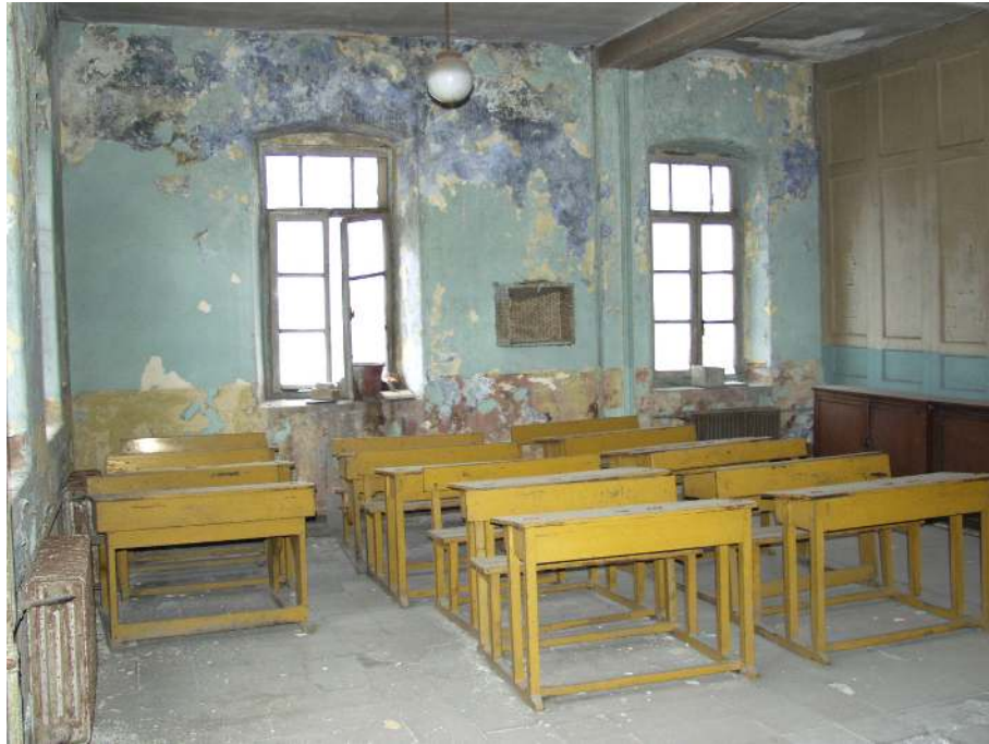
Şekil 6.64 Mekanın Kuzeydoğu Cephesi'ne bakan ahşap pencereleri.
