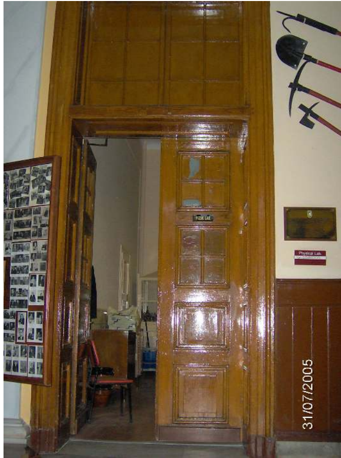
Şekil Ek 5. 4 Özgün ahşap derslik kapısı.
