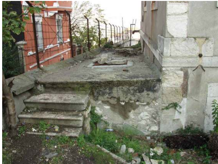
Şekil 6.110 Kuzeybatı Cephesi, muhdes set.
