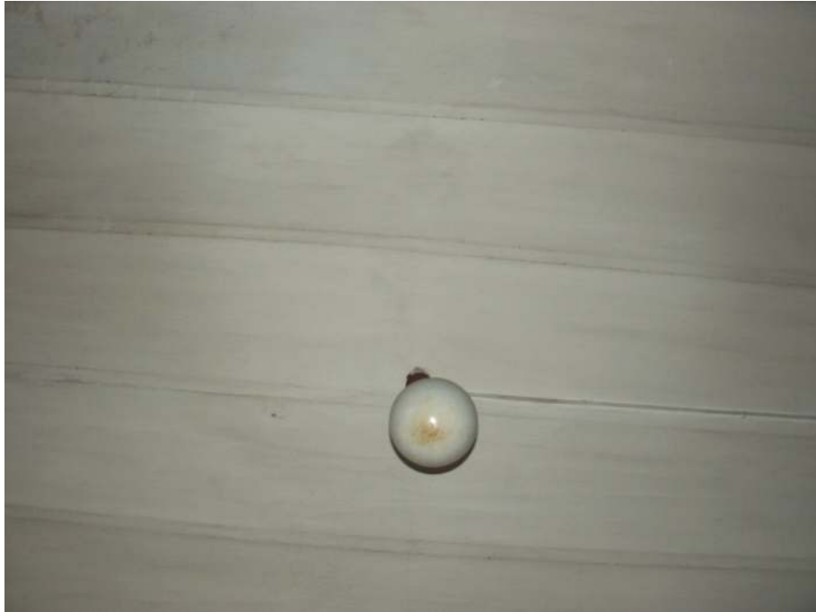
Şekil 6.39 Sıvalı olmasına karşın algılanabilen paslanmalar.
