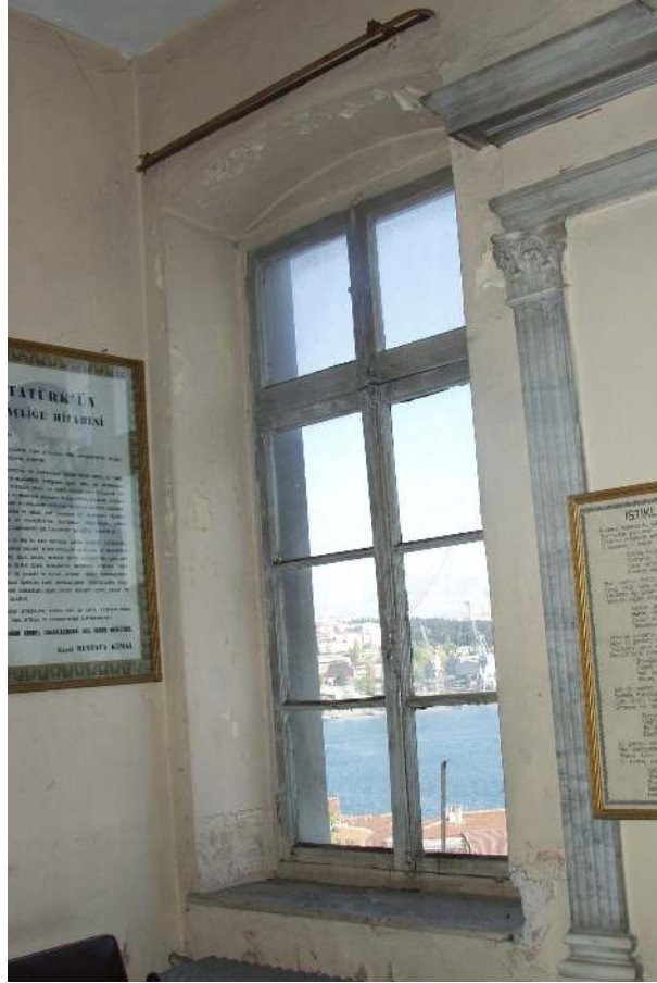
Şekil 6.29 Mermer ikonastasisin sol yanında yer alan özgün ahşap pencere.
