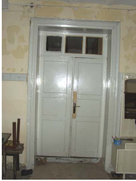
Şekil 6.7 B09 Mekanı ahşap giriş kapısı.
