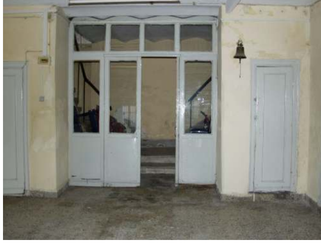
Şekil 6.13 Merdiven Holüne bağlantıyı sağlayan muhdes ahşap bölme.
