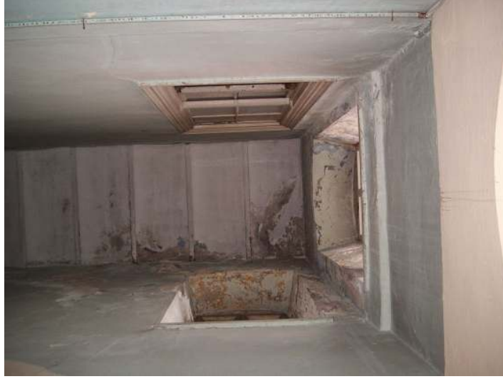
Şekil 6.75 Merdiven holü, sıvalı volta döşeme.
