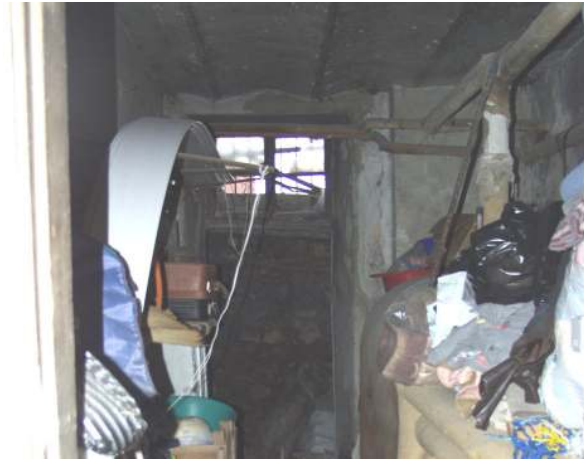
Şekil 6.8 B10 Kalorifer dairesinin tavanı ve penceresi.
