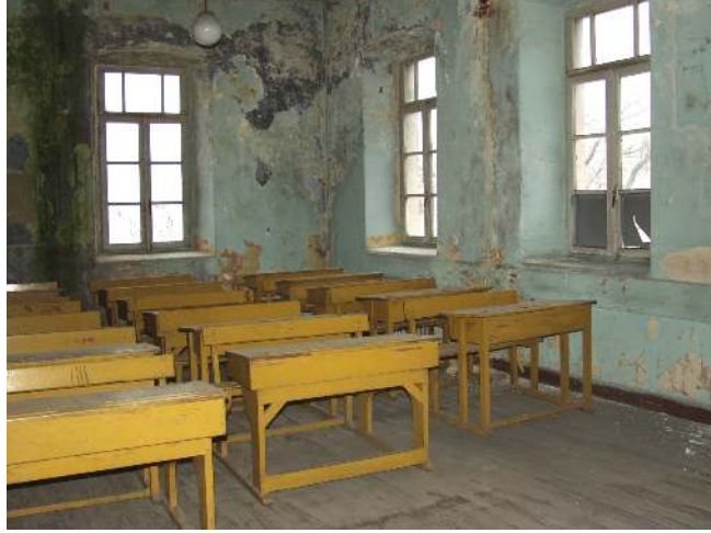
Şekil 6.55 102 sınıf mekanı ahşap döşeme kaplaması.
