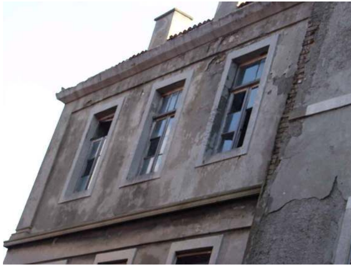
Şekil 6.112 Sonradan eklenen baca için yapılan tuğla örgü.
