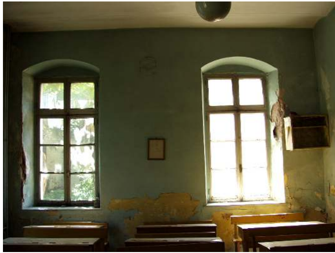
Şekil 6.20 Z01 Sınıf mekanı ahşap pencereler.
