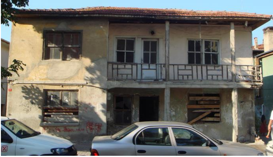
Şekil 4.33 : Tuzla'da Konut yapısının ön cephesi.
