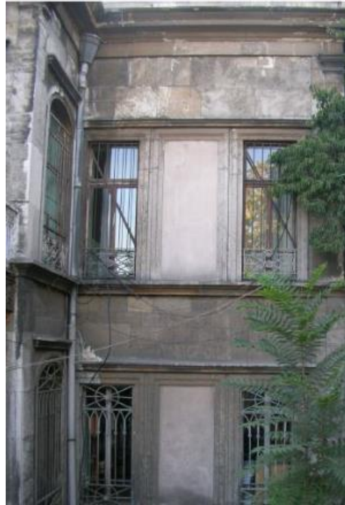
Şekil 4.22 : Abdullatif Suphi Paşa Konağı'nın dış duvarının dıştan görünüşü (Gener Deniz, 2008).
