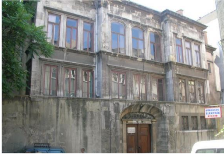
Şekil 4.20 : Abdullatif Suphi Paşa Konağı'nın sokak cephesi (Gener Deniz, 2008).
