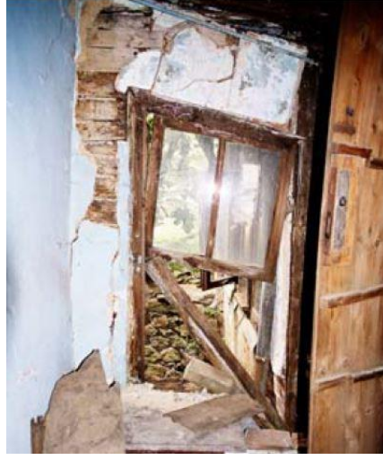
Şekil 4.6 : Beykoz Yalıköy Mediha Yaran Evi'nin dış duvarının içten görünüşü ve bağdadi çıtaları (Erdine, 2008).
