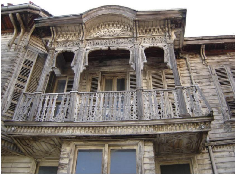
Şekil 4.3 : Avcı Mehmet Paşa Yalı'sının dış duvarının dıştan görünüşü (Elmas, 2007).
