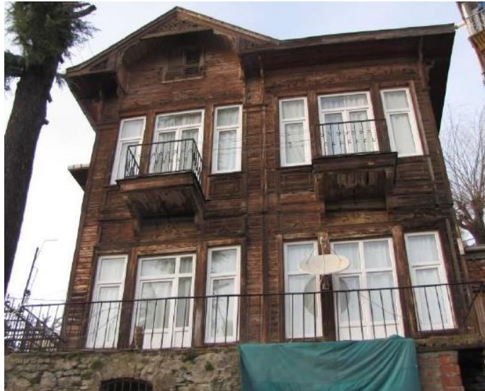
Şekil 4.12 : Sarıyer Yenimahalle Ali Osman Köse Evi'nin cephesi (Ekinci, 2014).
