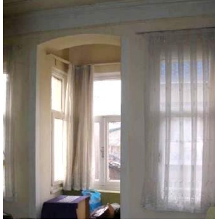
Şekil 4.26 : Balat Ayan Caddesi 14-18-22 Nolu Sıra Evler'in dış duvarının içten görünüşü (Verdön, 2007).
