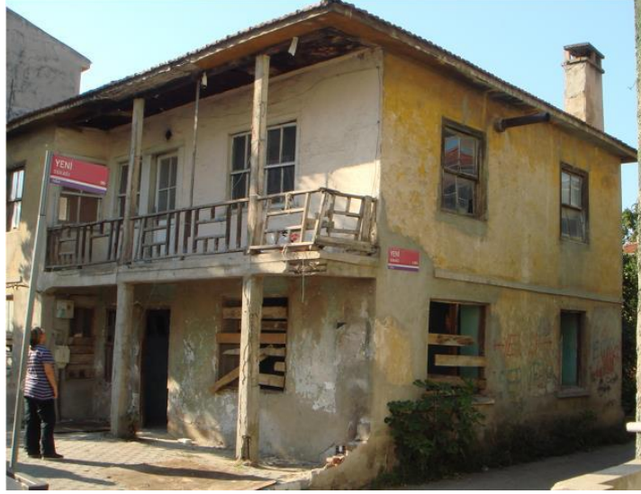
Şekil 4.34 : Tuzla'da Konut yapısının dış duvarlarının dıştan görünüşü.
