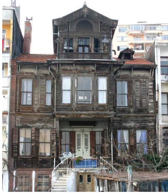
Şekil 4.15 : Sarıyer Yenimahalle 118 Nolu Yapı'nın ön cephesi (Atabeyoğlu, 2008).
