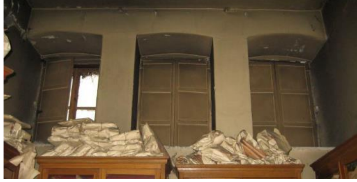
Şekil 4.21 : Abdullatif Suphi Paşa Konağı'nın dış duvarının içten görünüşü (Gener Deniz, 2008).
