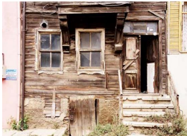
Şekil 4.5 : Beykoz Yalıköy Mediha Yaran Evi'nin dış duvarının dıştan görünüşü (Erdine, 2008).
