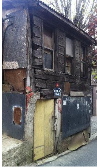
Şekil 4.18 : Bebek Manolya Sokaktaki Yapı'nın sokak cephesi (Yazıcıoğlu, 2015).
