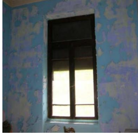
Şekil 4.29 : Silivri Anastase Stamoulis Evi'nin dış duvarının içten görünüşü (Dilber, 2010).
