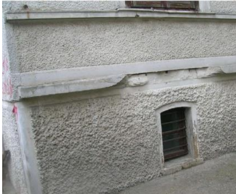
Şekil 4.28 : Silivri Anastase Stamoulis Evi'nin dış duvarının dıştan görünüşü (Dilber, 2010).
