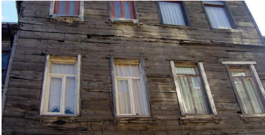
Şekil 4.11 : Fatih Erturan Ailesi Konutu'nun dış duvarının dıştan görünüşü (Aykut, 2013).
