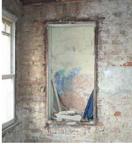
Şekil 4.24 : Balat Ayan Caddesi 14-18-22 Nolu Sıra Evler'in dış duvarının içten görünüşü ve dış duvar gövde malzemesi tuğla (Verdön, 2007).
