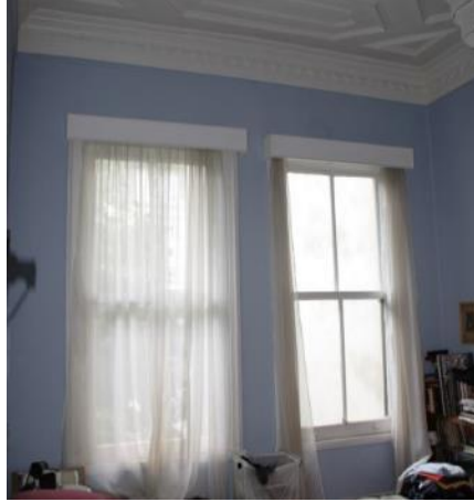
Şekil 4.17 : Sarıyer Yenimahalle 118 Nolu Yapı'nın dış duvarının içten görünüşü (Atabeyoğlu, 2008).
