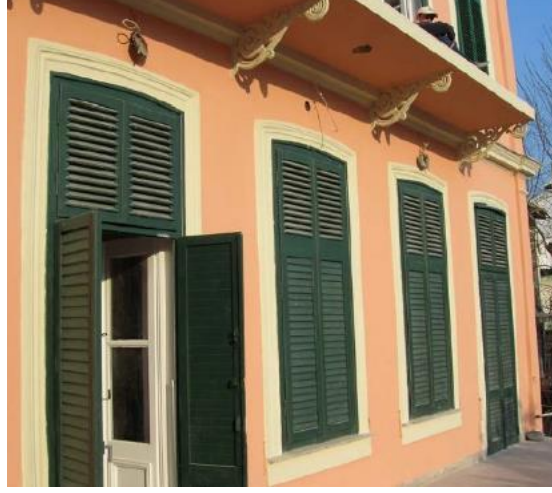
Şekil 4.31 : Yeşilköy Şengör Evi'nin dış duvarının dıştan görünüşü (Gümülcineliolu, 2008).
