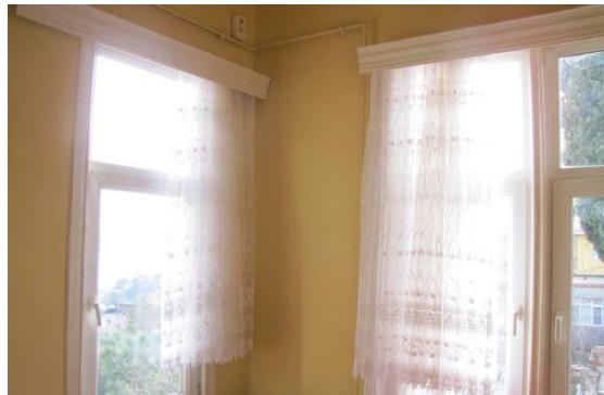
Şekil 4.14 : Sarıyer Yenimahalle Ali Osman Köse Evi'nin dış duvarının içten görünüşü (Ekinci, 2014).
