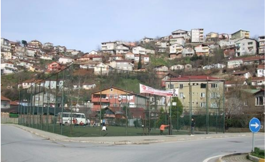
Şekil 20. Topağacı Mahallesi Küçüksu Caddesinden Gecekondular Yapılarına Bakış
