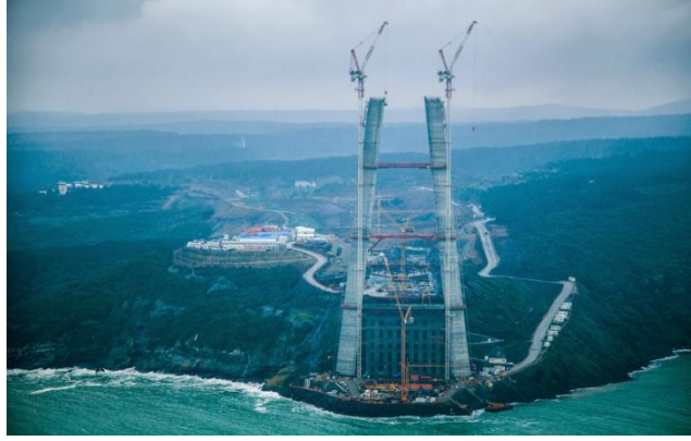
Şekil C.20: Üçüncü Boğaz Köprüsü ,2015
