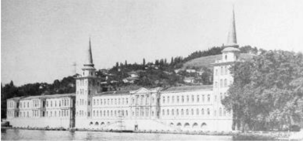
Figure 2.38 Kuleli Barrack Used as quarantine place in 1838. Nuran Yıldırım. İstanbul Boğazında Karantina Uygulamaları. Yeni Deniz Mecmuası, 53, March 2016.
