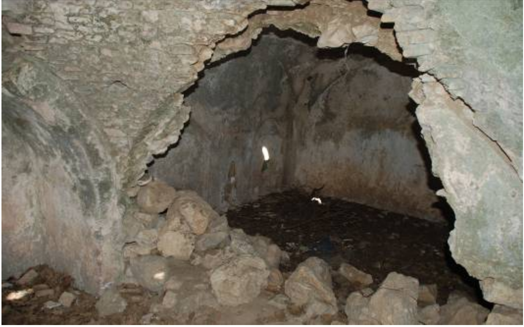
Fotoğraf 114-Pili Kalesi Güzelce Ali Paşa Hamamı, kubbesi küçük mekâna bakış
