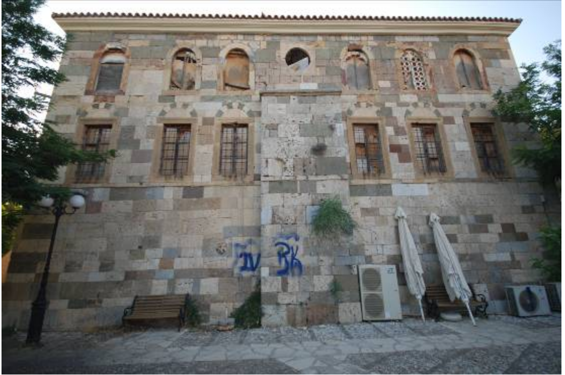
Fotoğraf 6-Lonca Cami, güney cepheden görünüş
