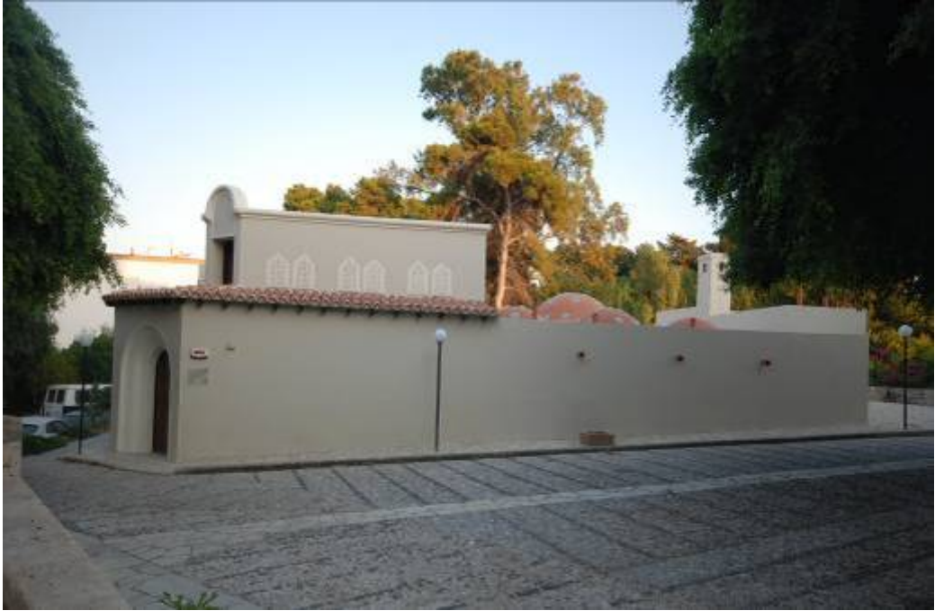
Fotoğraf 28-Bakrat Hamamı, restorasyon sonrası genel görünüş
