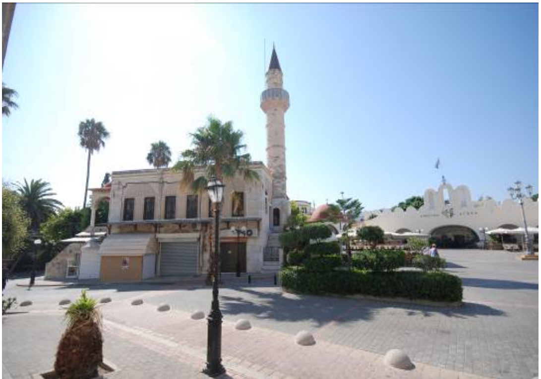
Fotoğraf 55-Defterdar cami, kuzeybatı cepheden bakışla genel görünüş
