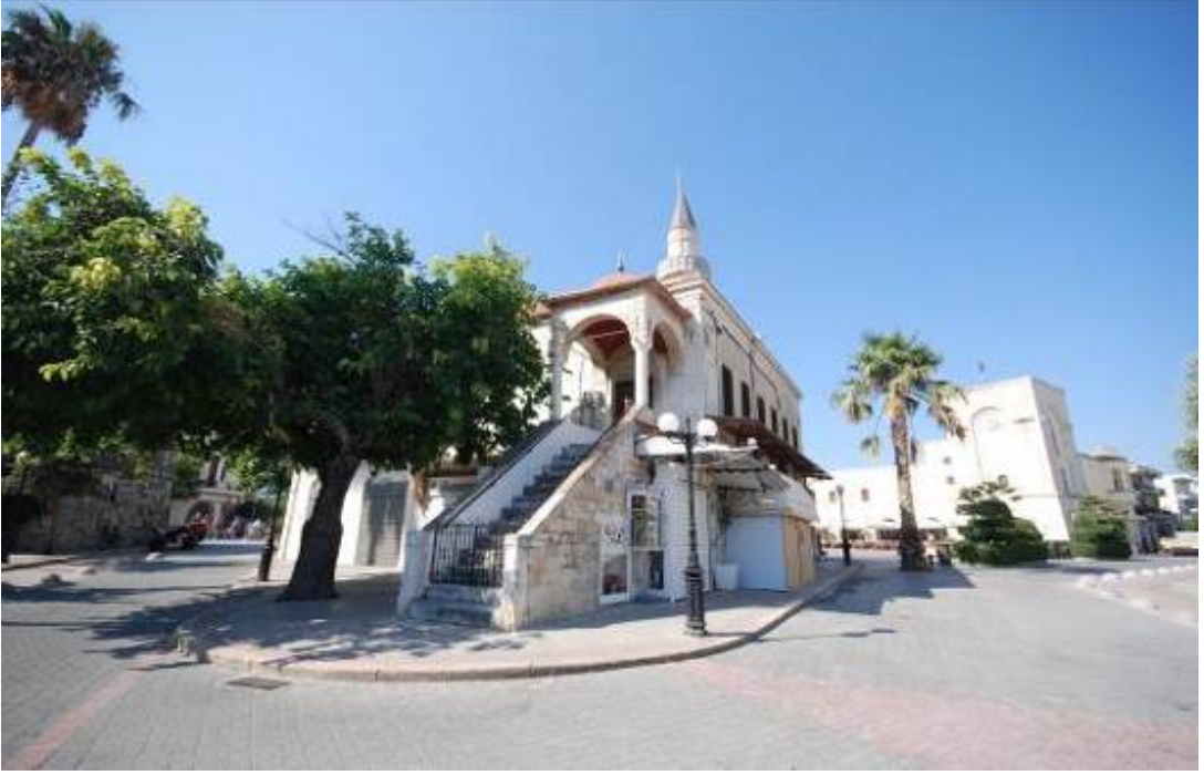
Fotoğraf 58-Defterdar Cami, kuzeydoğu cepheden genel görünüş
