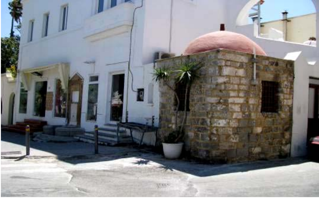
Fotoğraf 104-Hacı Paşa Türbesi kuzeybatıdan genel bakış
