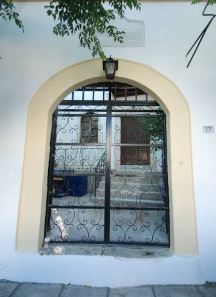
Fotoğraf 49-Atik Cami, kuzey cephedeki avlu kapısı
