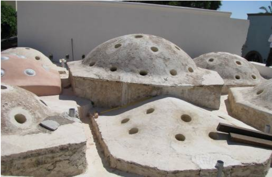
Fotoğraf 30-Bakrat Hamamı, kubbe sistemi
