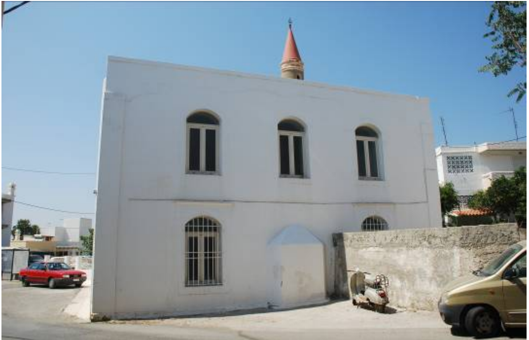
Fotoğraf 73-Germe Cezayirli Gazi Hasan Paşa Cami güney cephesi
