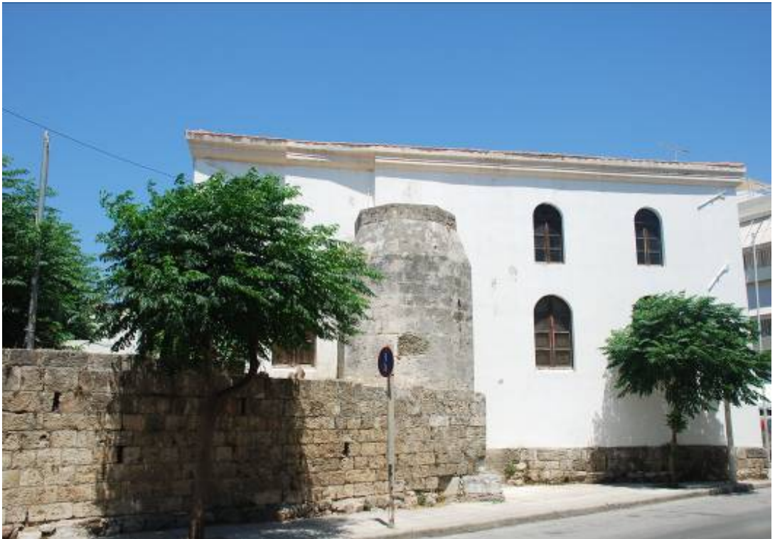
Fotoğraf 47-Atik Cami, batı cephesi
