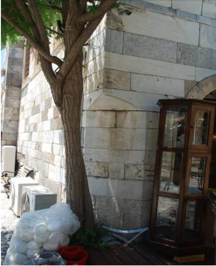
Fotoğraf 8-Lonca Cami, güneydoğu köşedeki pahlanmış köşe
