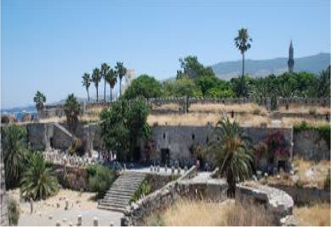
Fotoğraf 86-Narince Kalesi Sultan Süleyman Cami, kale duvarlarının içindeki yapıya genel bakış
