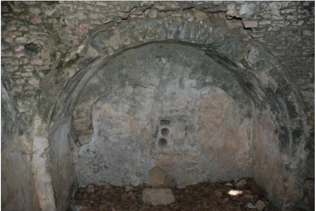
Fotoğraf 115-Pili Kalesi Güzelce Ali Paşa Hamamı, büyük kubbeli mekân ve bu mekânın kubbe geçişleri
