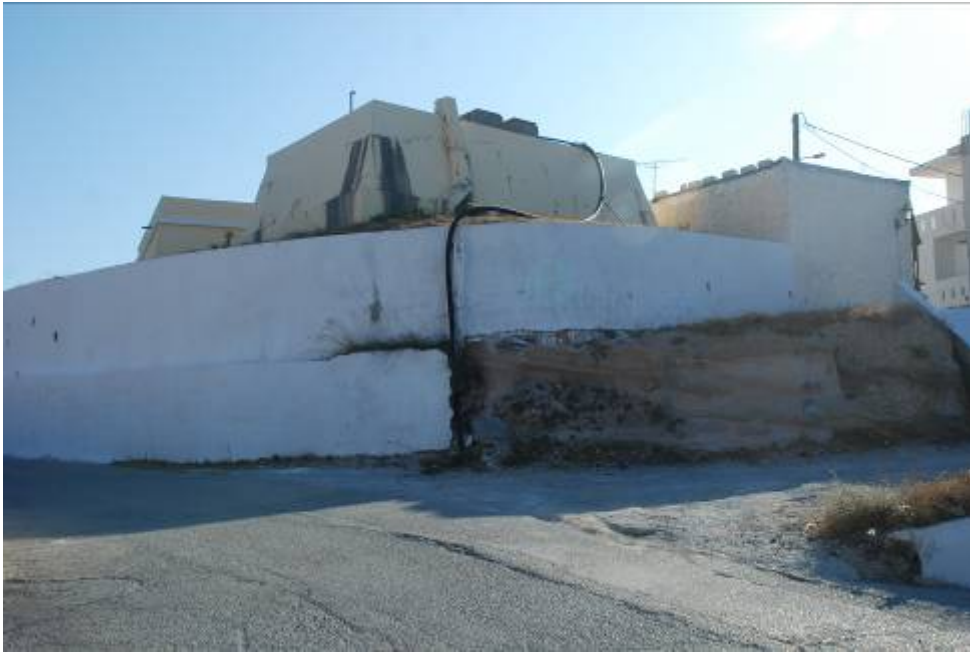
Fotoğraf 151-Kefalos Kalesi'nde su sarnıçlarının yerinde su deposu yapıları
