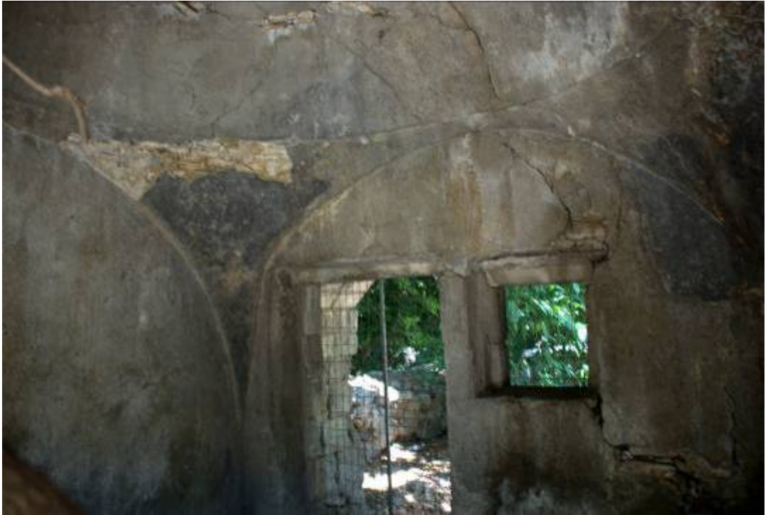
Fotoğraf 37-Lonca Mezarlığındaki müştemilat yapısının içi ve kubbeye geçiş sistemi
