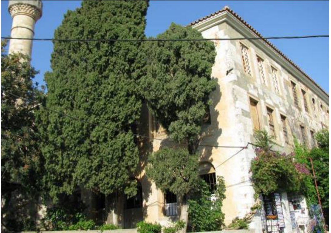
Fotoğraf 2-Lonca Cami, kuzeybatı köşeden görünüş
