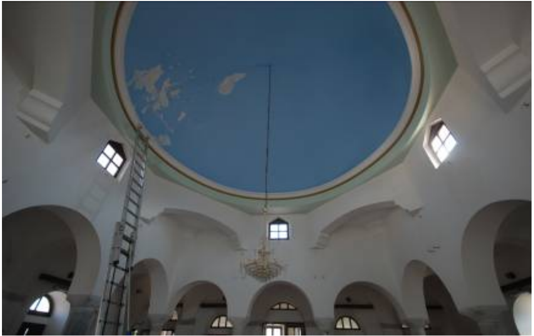
Fotoğraf 65-Deftardar Cami, örtü ve geçiş sistemi
