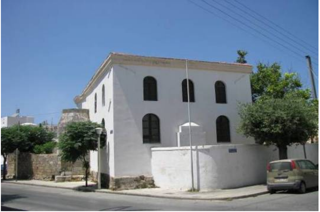
Fotoğraf 46-Atik Cami, güney cepheden bakışla genel görünüş
