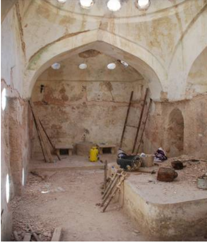
Fotoğraf 29-Bakrat Hamamı, batıdaki eyvandan, sıcaklık mekânı ve doğudaki eyvana bakış
