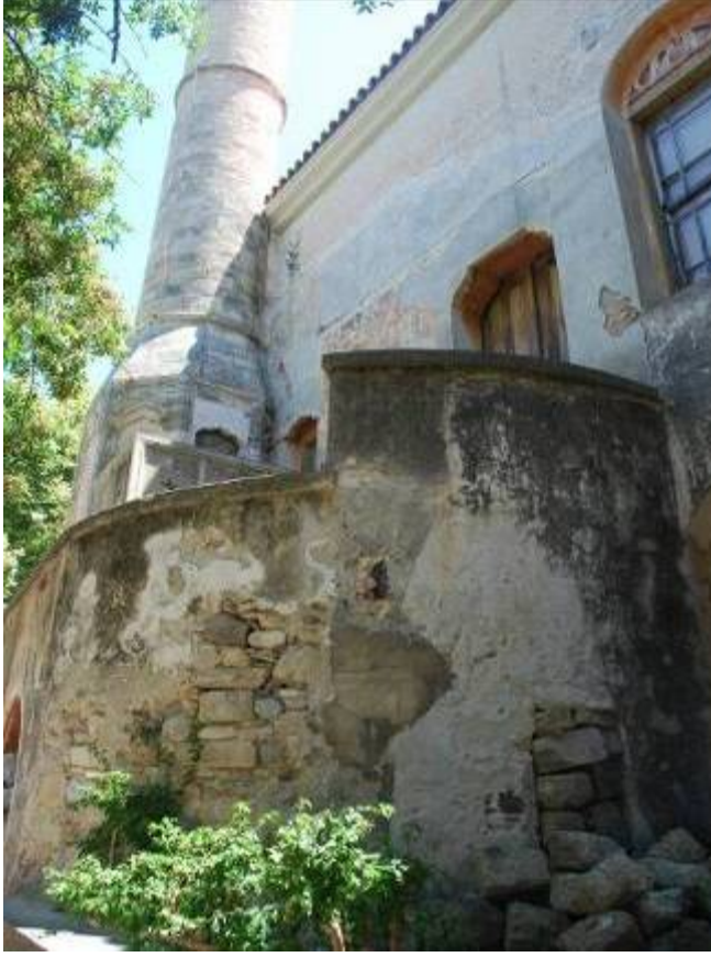
Fotoğraf 3-Lonca Cami, kuzey cephedeki son cemaat yerine çıkışı sağlayan merdiven bütünlüğü
