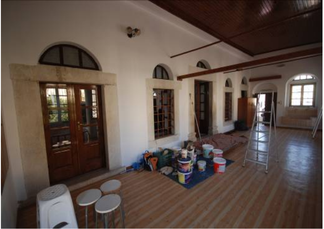
Fotoğraf 63-Defterdar Cami, kuzeydoğu köşeden son cemaat yeri
