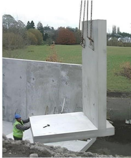
Şekil 2.4. Betonarme Konsol İstinat Duvarı [14]
