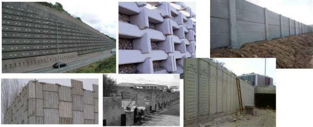
Şekil 2.10. Prefabrike İstinat Duvarı
