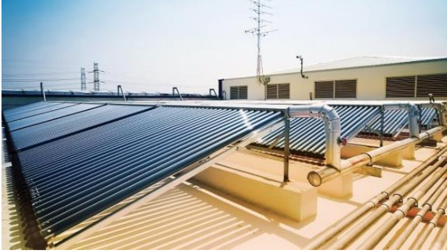
Şekil 11. Güneş enerjili ısıtma sistemine ait dış paneller ve tesisatı (URL-17, 2024)
