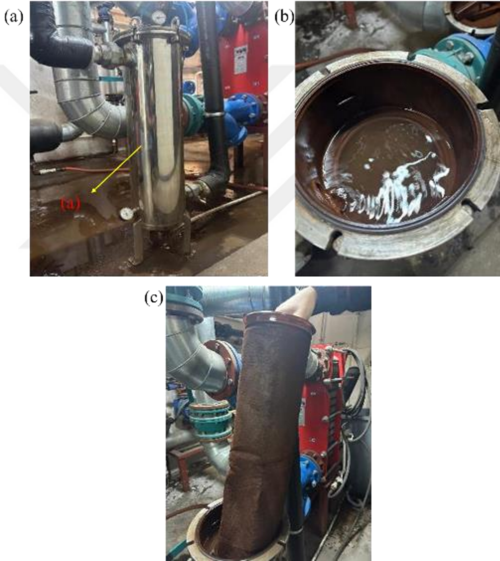
Şekil 16. (a) Torbalı fitrenin gövdesi, (b) üst kapağının açılmış hali ve (c) 25 \mu\text{m} 'luk pislik tutucu fitre
