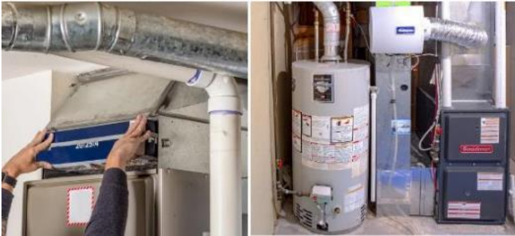
Şekil 8. Tipik bir ısıtma fırınının görünüşü (URL-4, 2024)
