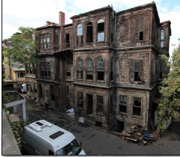
Şekil 9: Güney cepheden görünüş 172
