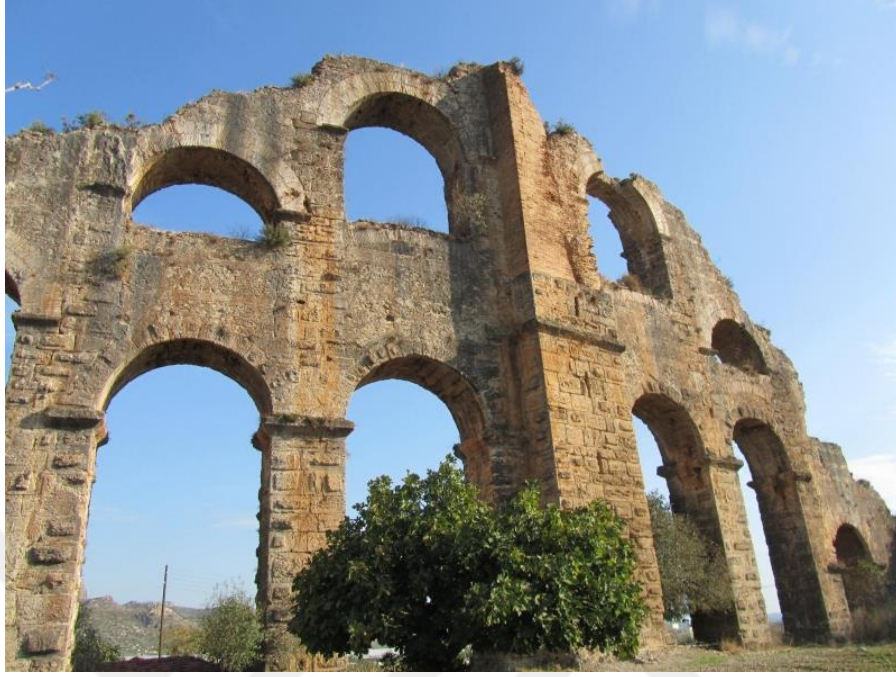
Şekil 27 154 : Aspendos su yolu basınç azaltma kulesi
