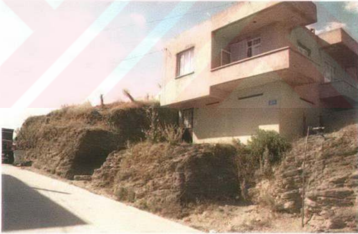
Şekil 6.12 : Selçuk ilçesi yerleşim alanında kaya zemine oturtulmuş yapı.
