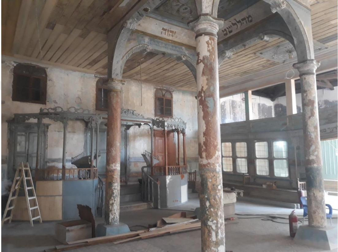
Şekil 69: Restorasyon Sürecindeki ETS Hayim Sinagogu
