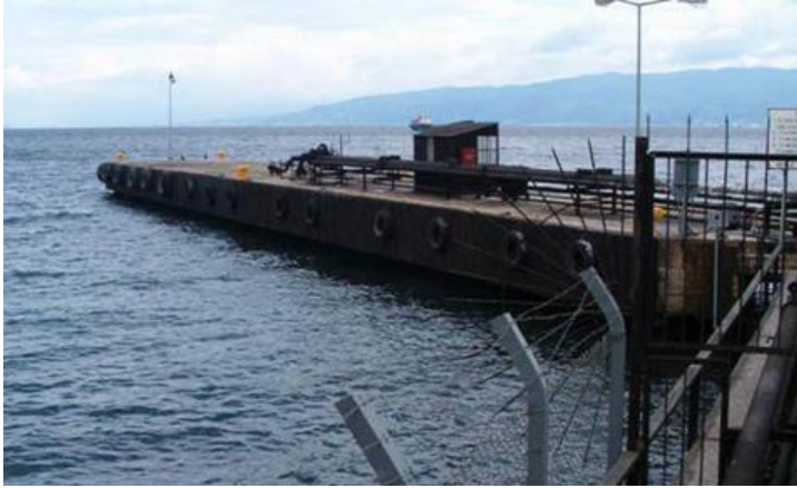
Şekil 3.17 : Karayolları Tavşancıl Asfalt Tesisleri.
