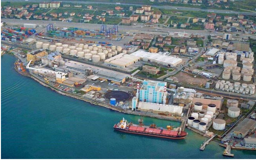
Şekil 3.11 : Gübre Fabrikaları T.A.Ş Yarımca Tesisleri.
