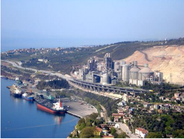
Şekil 3.14 : Nuh Çimento Liman Tesisi.
