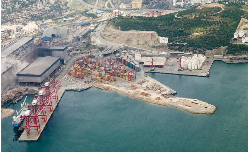
Şekil 3.19 : Yılport Konteyner Terminali ve Liman İşletmesi.
