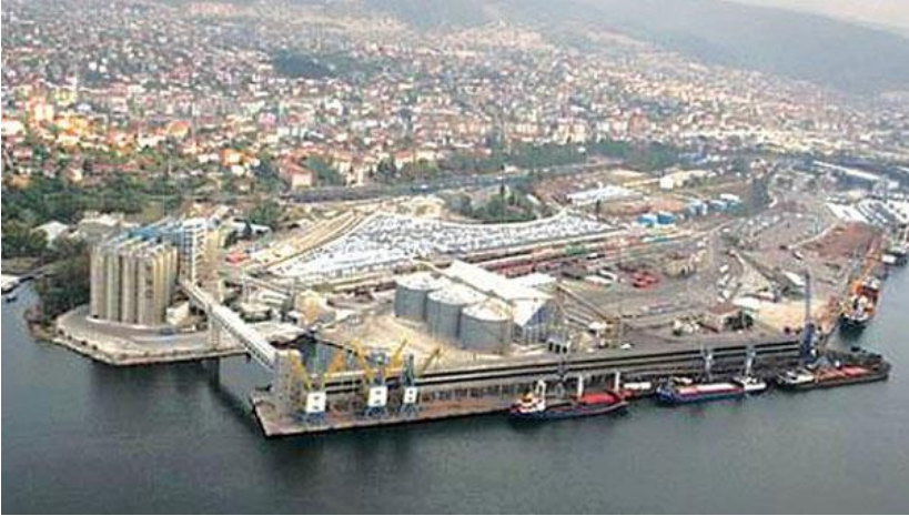
Şekil 3.6 : 3.1.5 TCDD Derince Liman Tesisi.
