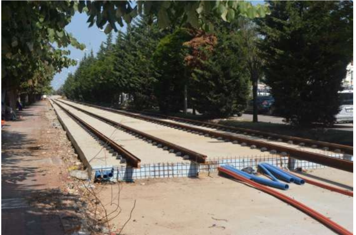
Foto 24: Valilik Mevkiindeki Akçaray Tramvay Çalışması
