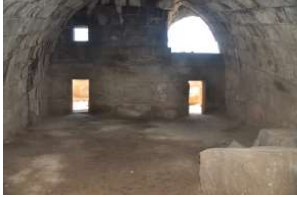
Ek 25: Trapezoidal Tonozdaki İç Tonoza geçişi sağlayan kapılar.
