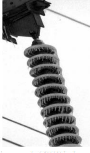
Şekil 2.8. Buzlanma olayı sırasında standart 500 kV izolatör dizisinde buz birikimi [25]
