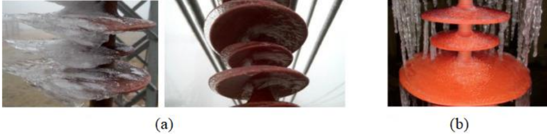
Şekil 2.12. İzolatör üzerinde ıslak büyüme buzlanması [37]
