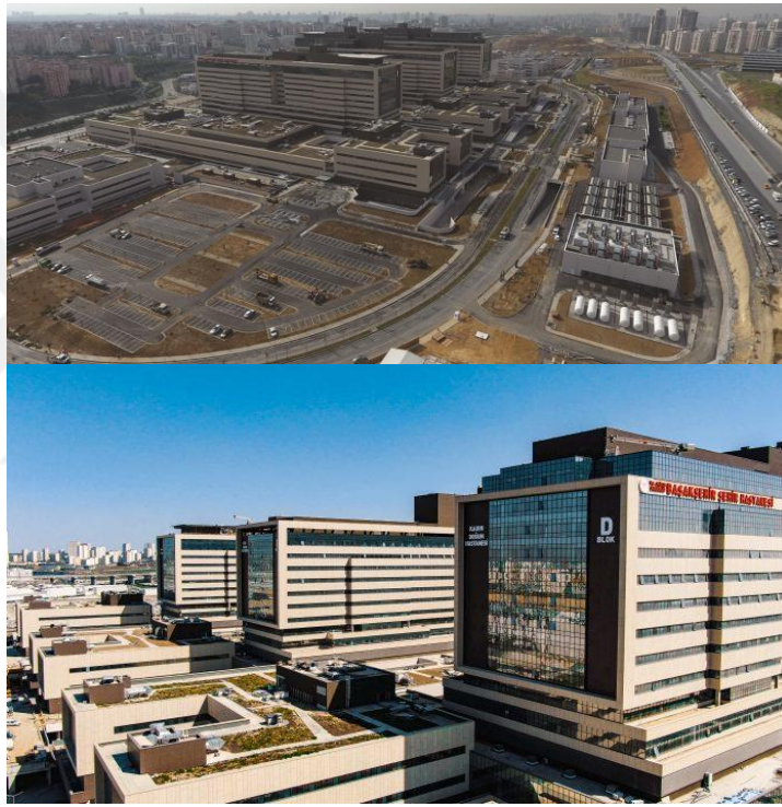
Şekil 7. Başakşehir Çam ve Sakura Şehir Hastanesi
