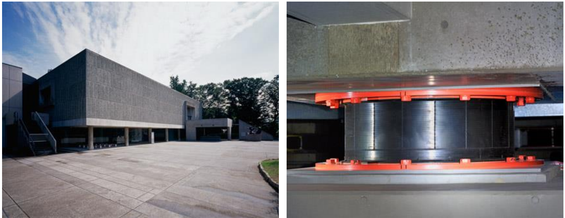
Şekil 15. Ulusal Batı Sanatları Müzesi ve uygulanan sismik izolatörler
