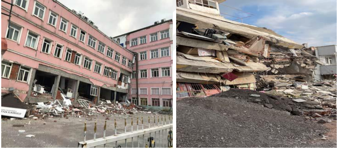
Şekil 1. Kahramanmaraş depremi nedeniyle binalar çöktü
