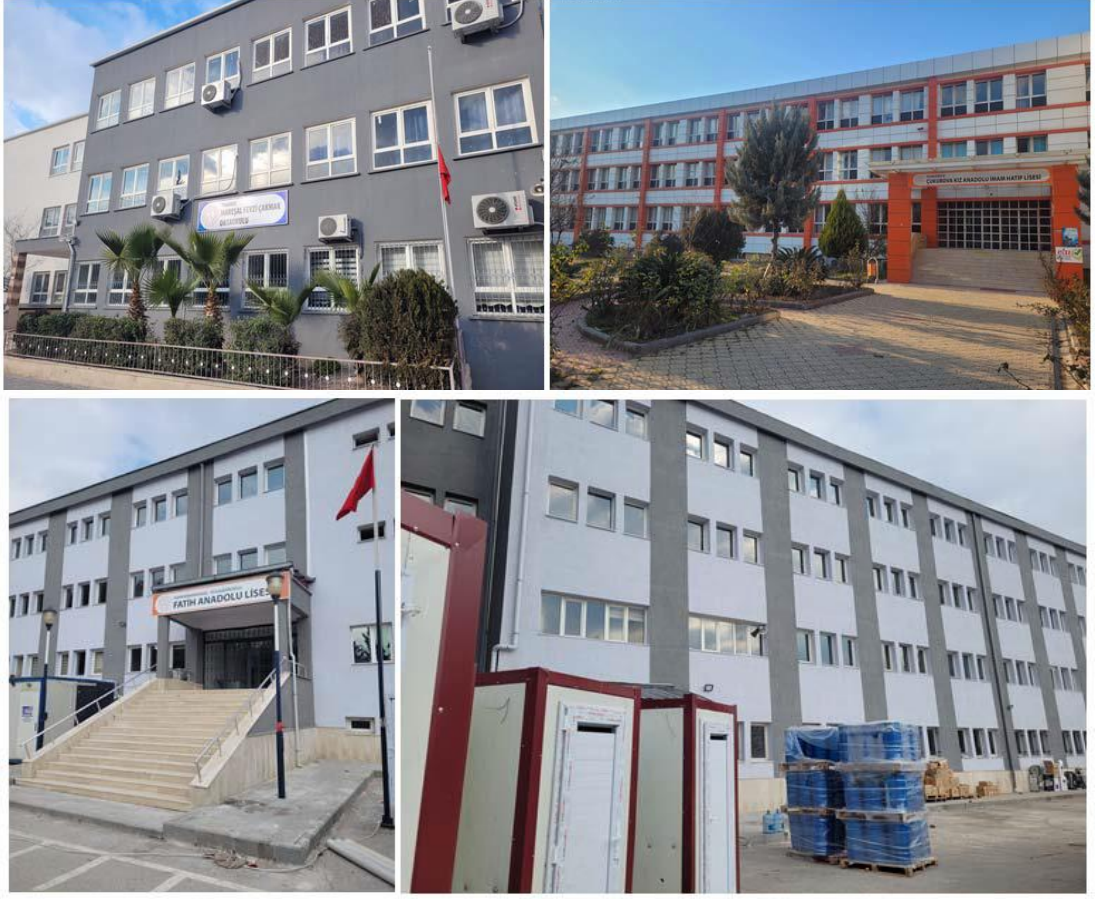
Şekil 17. Deprem bölgesinde bulunan ve hiç hasar görmeyen bazı güçlendirilmiş okul binaları
