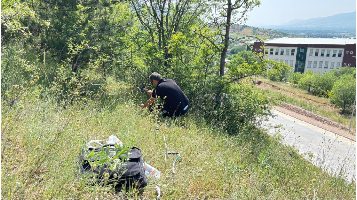
Şekil 3.8. Elektrotların yere çakılması
